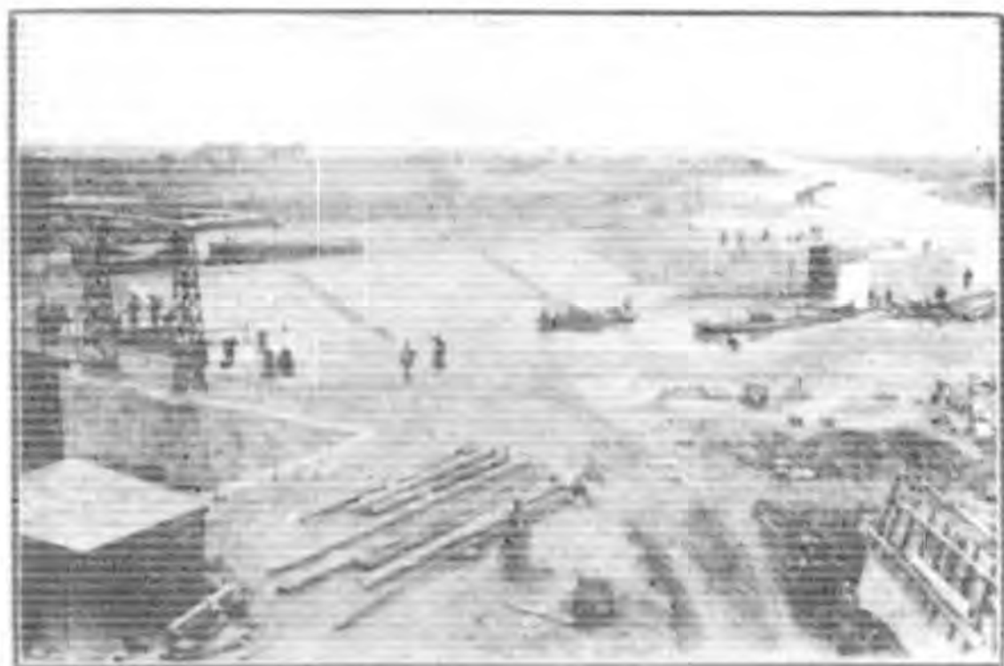
海河治標工程北運河閘閘門全視景
