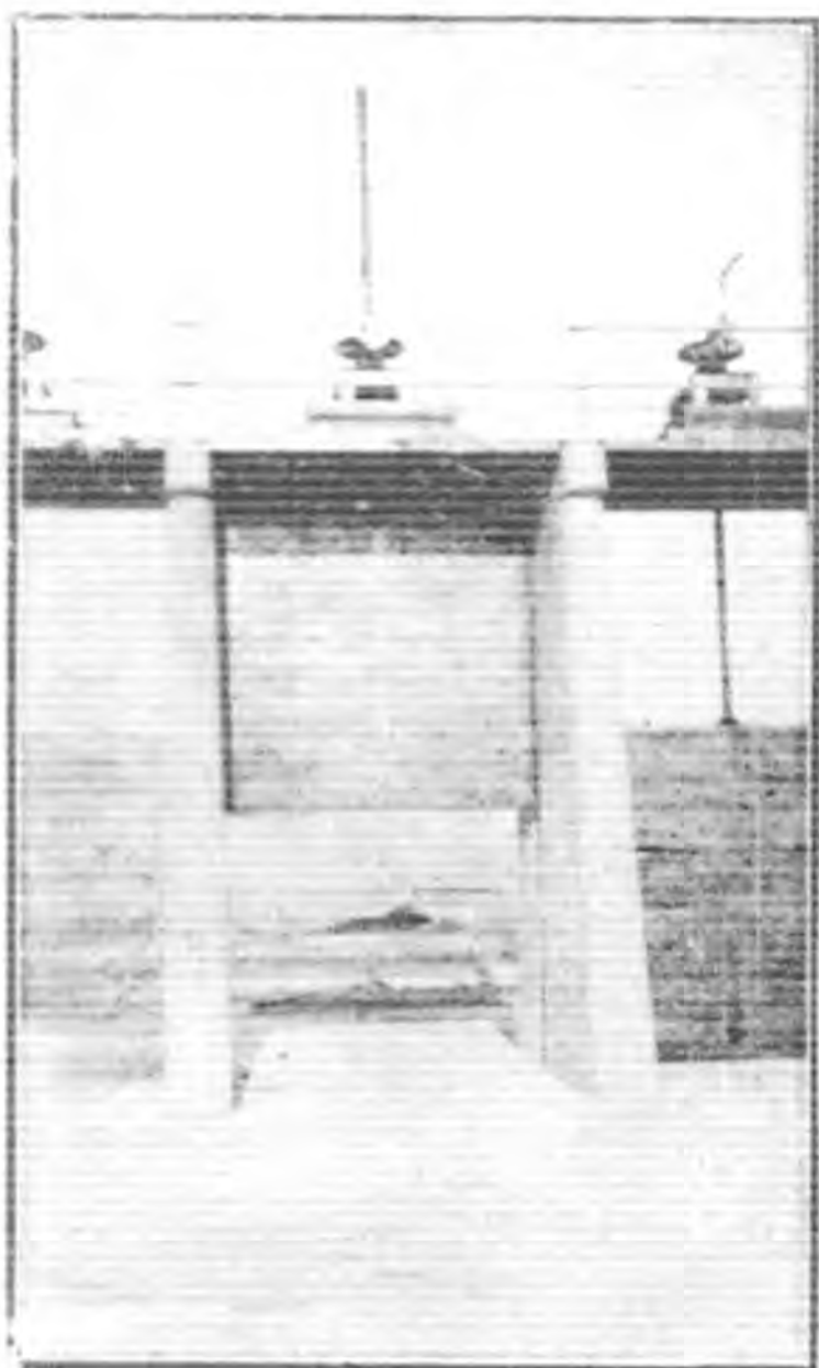
海河治標工程放淤區域洩水閘閘門及啟閉機械
