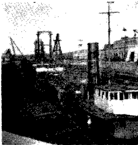
船舶在塢修理情形
