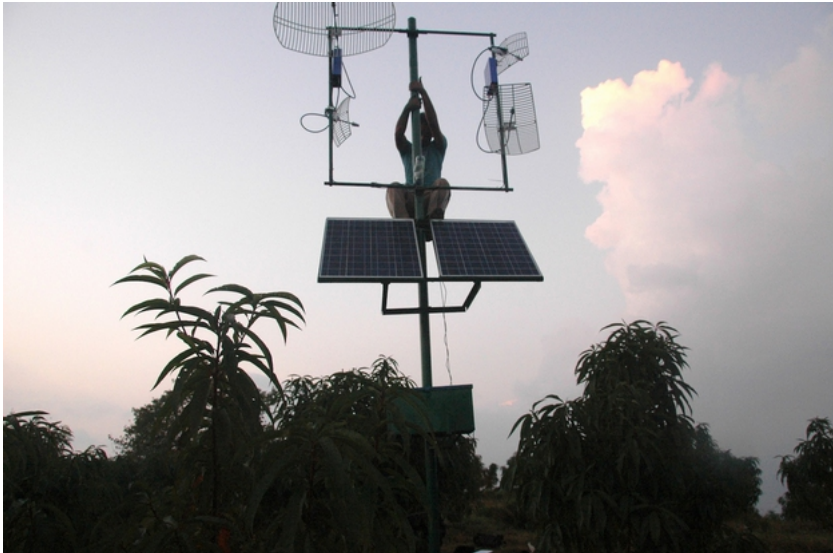
Figura EcA 7: Últimos toques a la repetidora solar, Red de Kumaon
