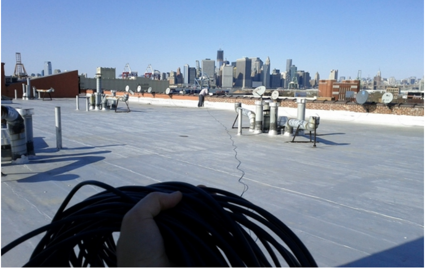
Figura EcOTI 5: Tendiendo el cable para instalar un nodo en el techo de un edificio al norte de Coffey Park
