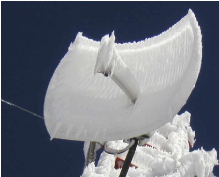
Figura ALT 17: Efecto del hielo en una parabólica de rejilla
