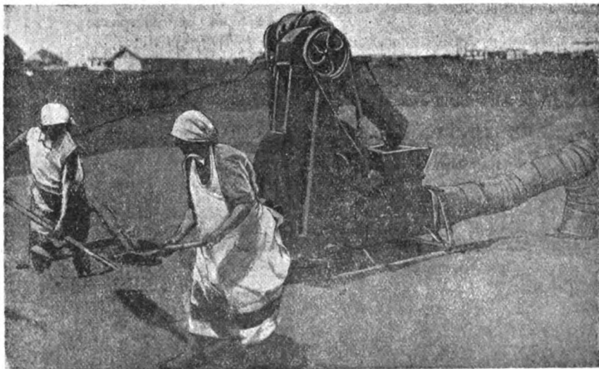
Зернопульта конструкції т. Валає—старшого агронома зернорадгоспу ім. Косіора. Зернопульта просушує за одну добу 100 тонн зерна. На фото: Зернопульта в роботі
