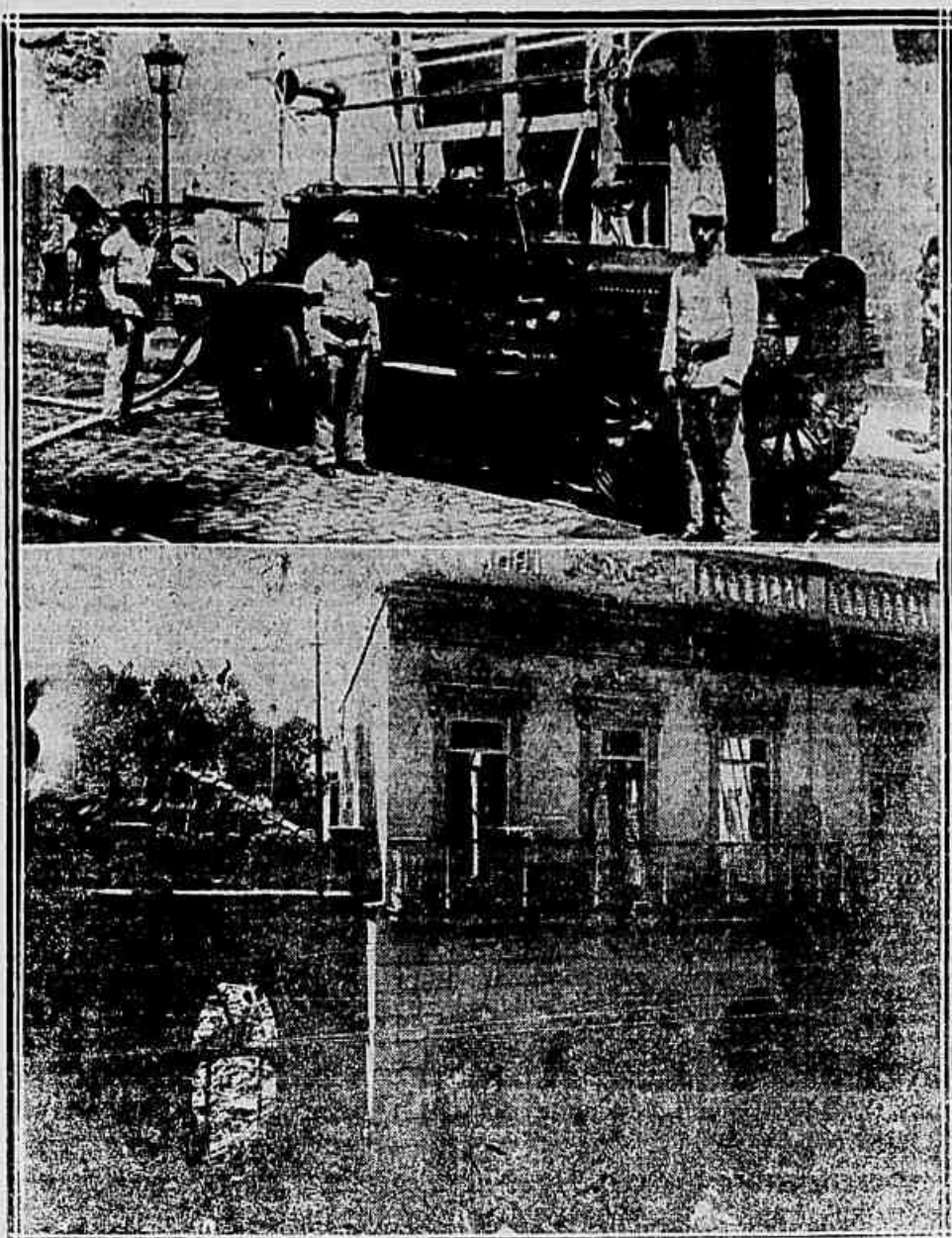
AO ALTO, UMA BOMBA FUNCIONANDO; EM BAIXO, UM ASPECTO DO ARCHIVO DO CONSELHO DESTRUIDO E O PREDIO CONTIGUO TAMBEEM DESTRUIDO PELO FOGO
