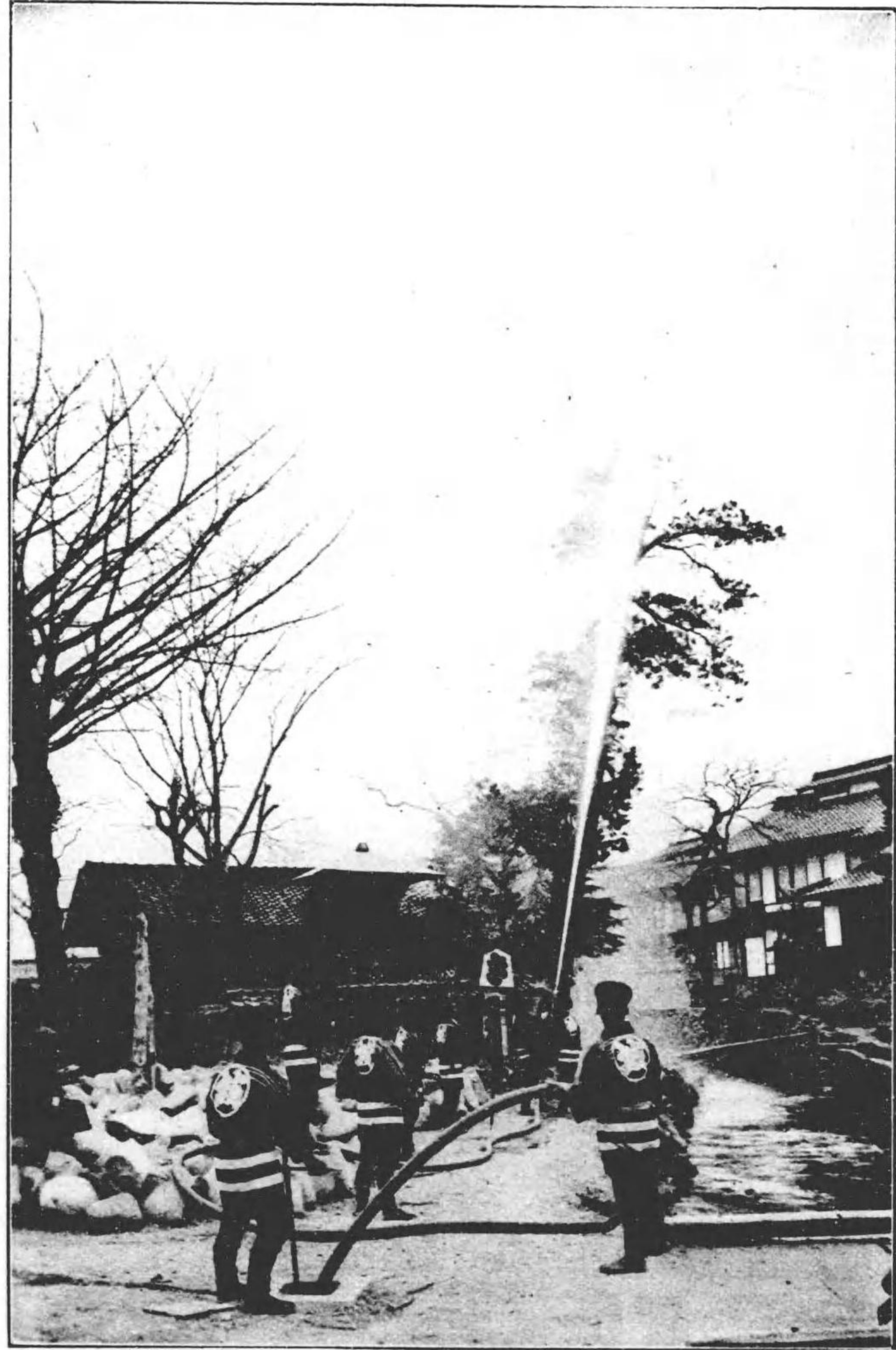
小牧水道消火栓試験
