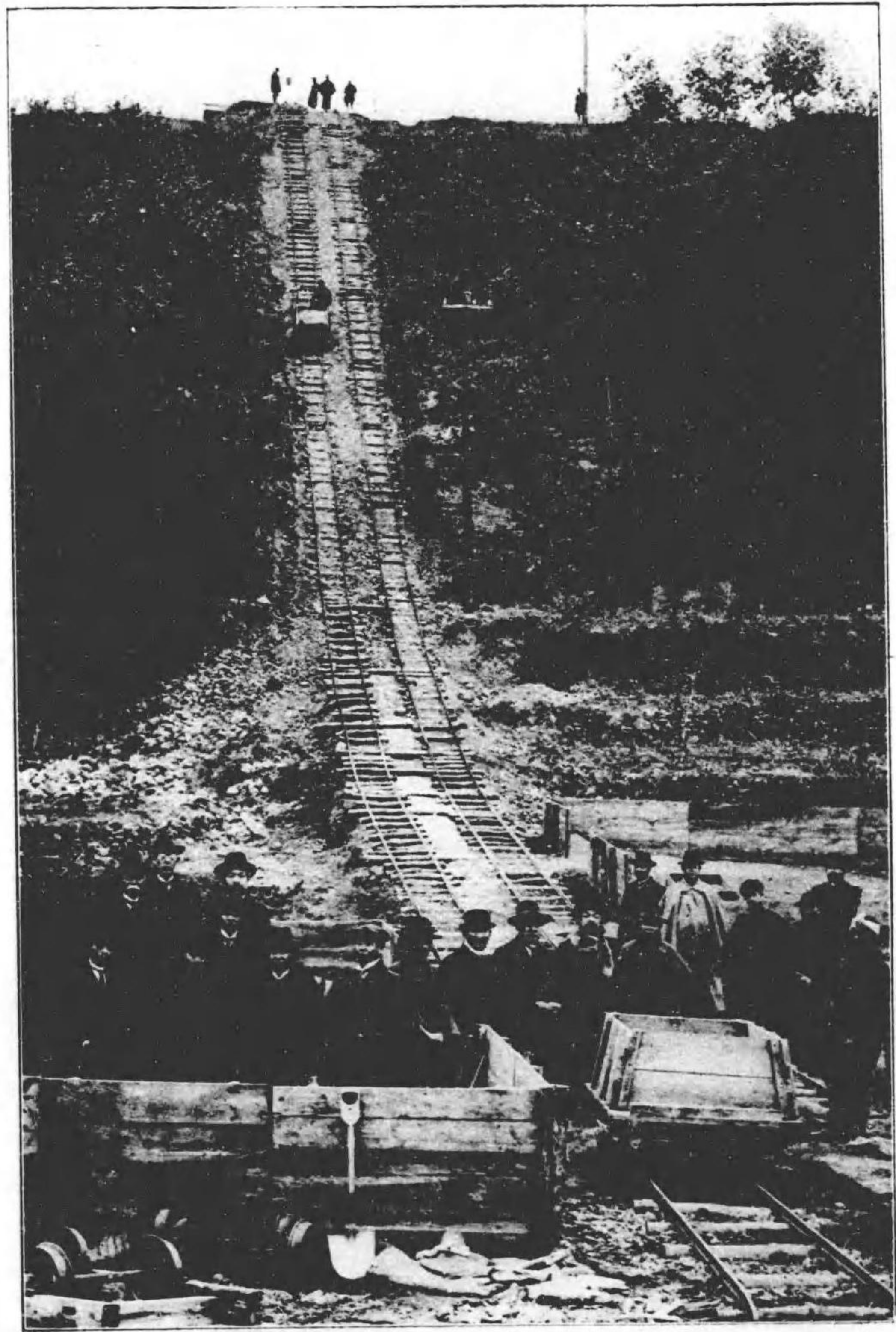
搬運揚捲働電料材地水淨
