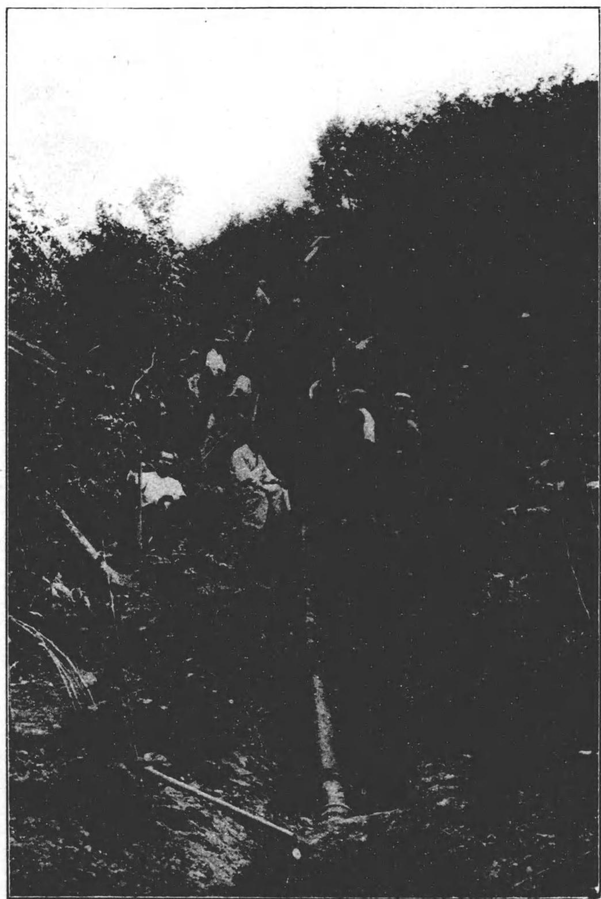
小牧水道送水鐵管埋設
