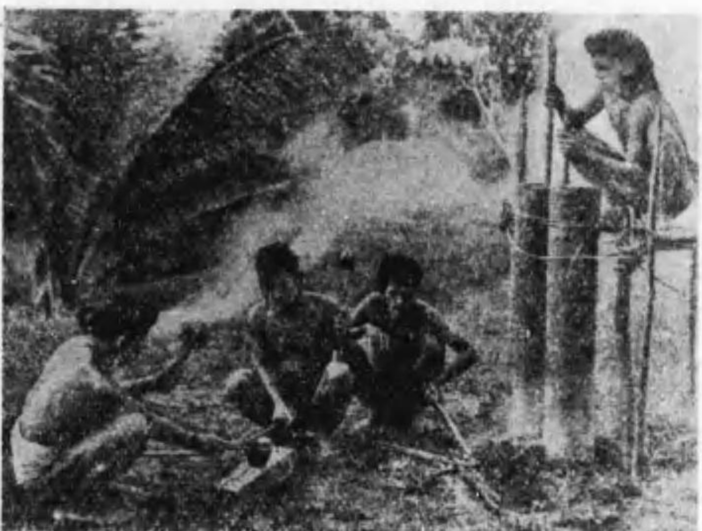
第三六圖 豎筒式鞴と石槌とを使用して鍛冶を行ふ
