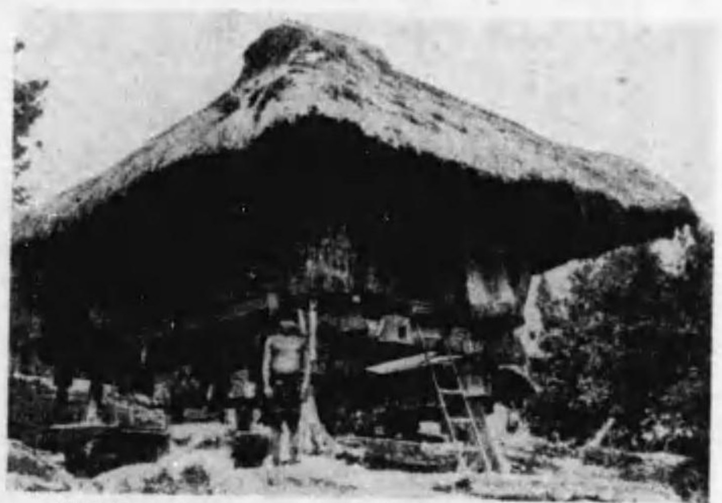
第九圖 イフガオ族の四角形の家 壁は上方ほど外に傾いてゐる ルスン島北部
