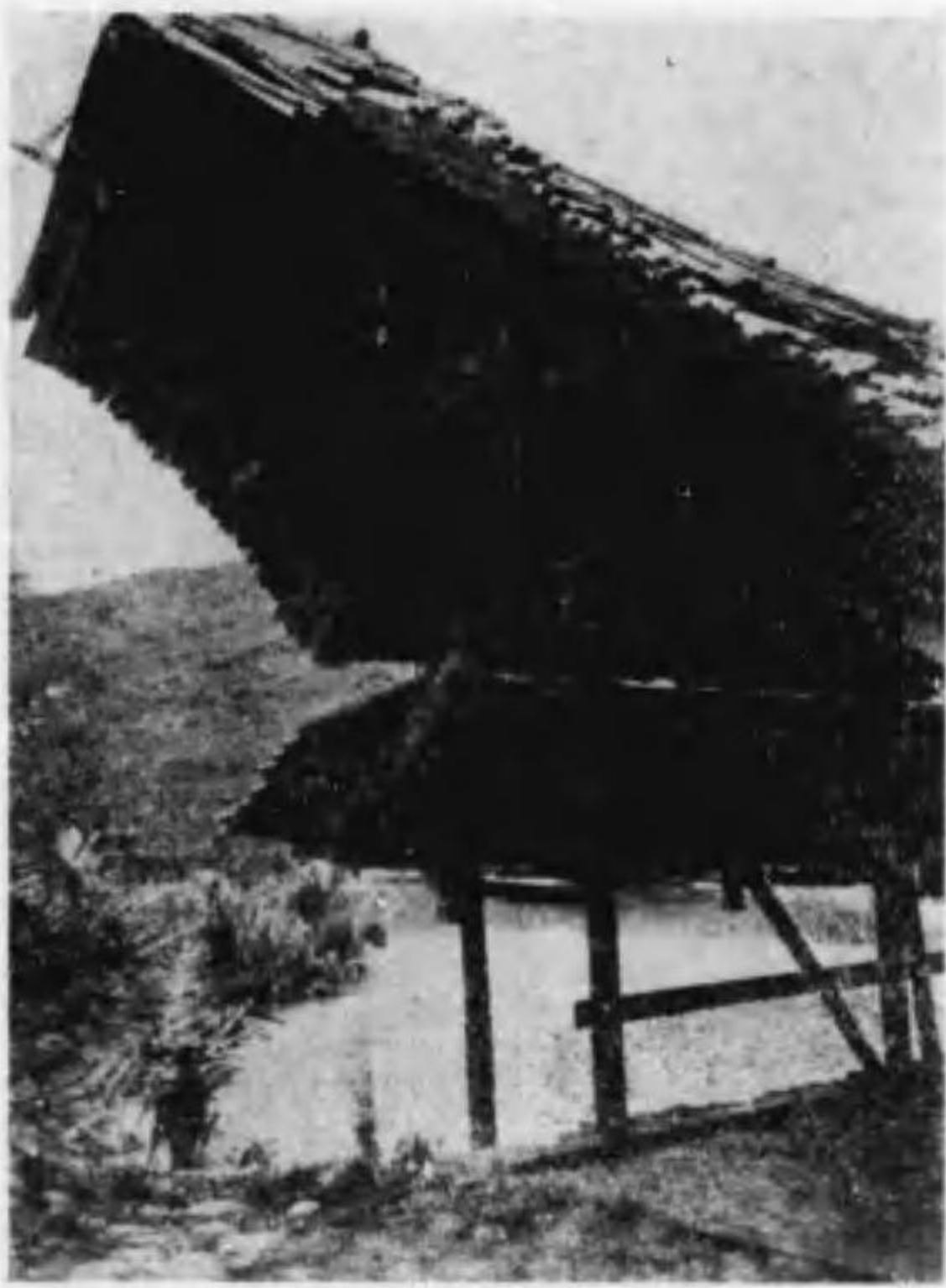
第一八圖 中央セレベス パラン河に架せられた橋
