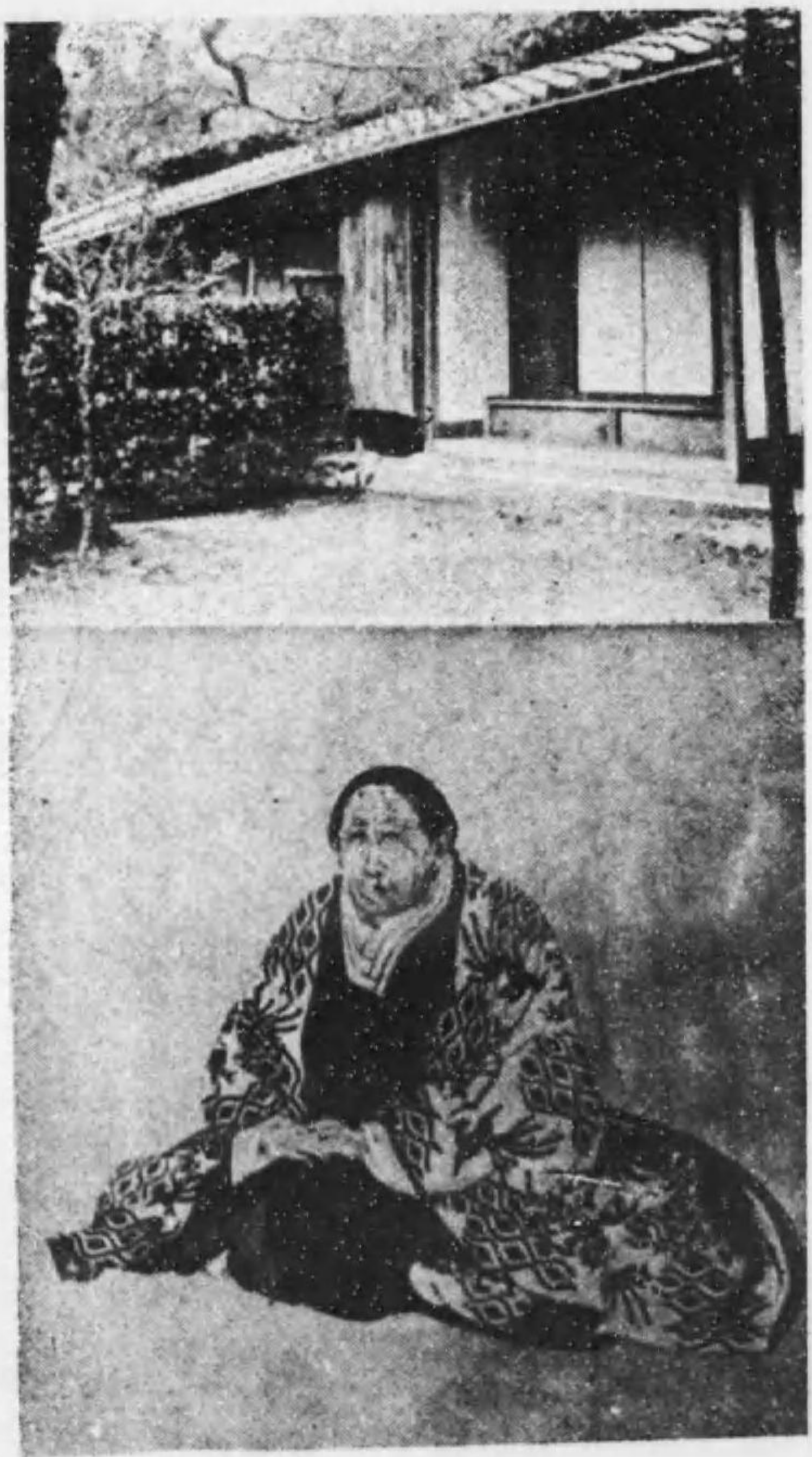
津崎村岡 上圖は洛西北嵯峨細谷の直指庵にて村岡の隱栖せし庵下圖は村岡の繪像である（婦人の龜鑑の項参照）
