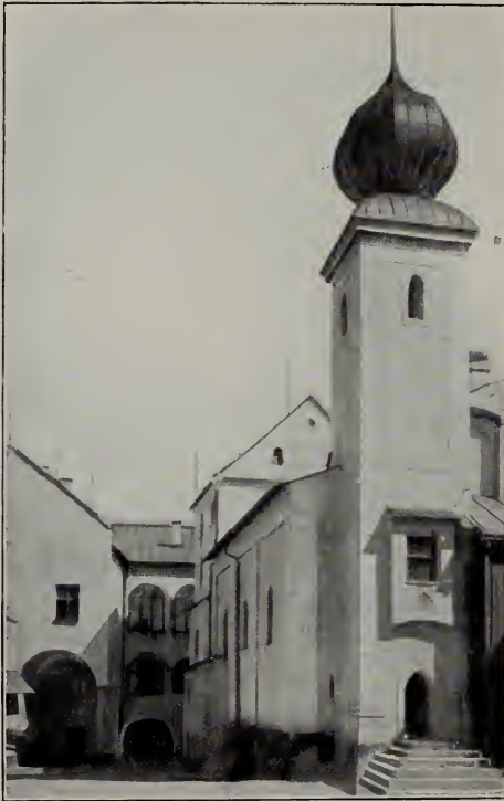
Abb. 40. Oberhaus. St. Georgskapelle.
