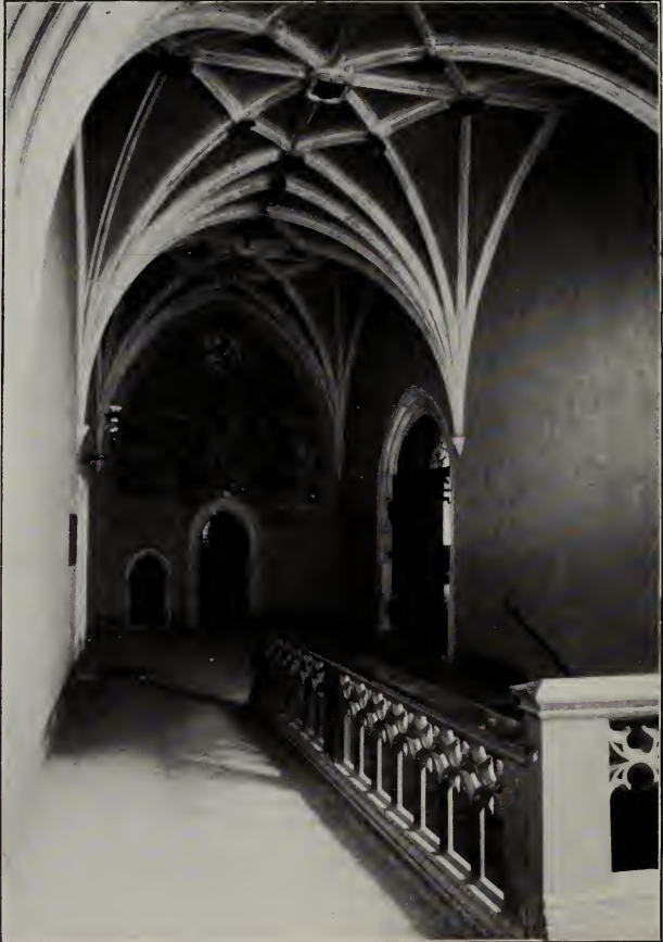
Abb. 42. Rathaus. Gewölbe im Stiegenhaus von 1446.
