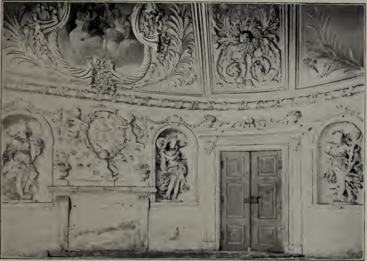
Abb. 96. Ehem. Luftschloß Hadklberg. Gartenfaal.
