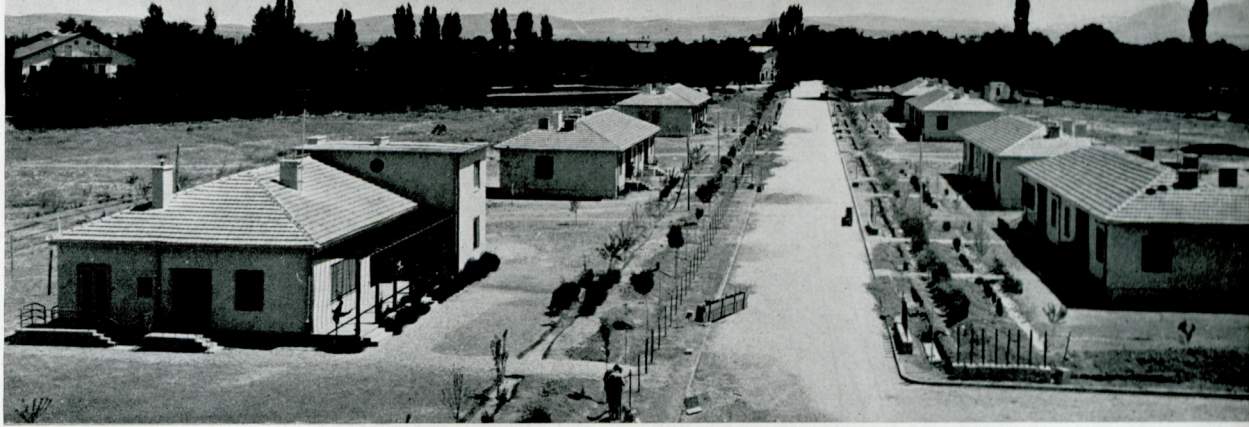
Les logements du personnel de la fabrique
