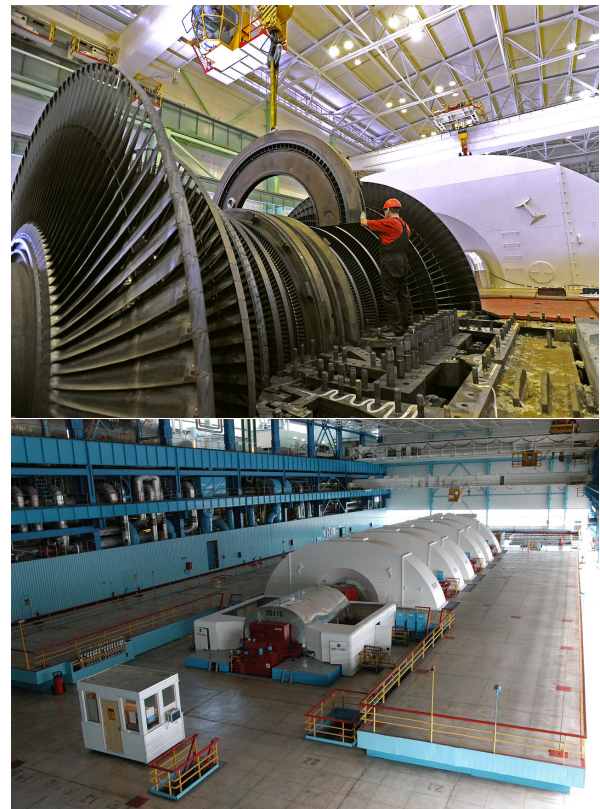
FIGURE 5.34 – Une des turbines de la centrale nucléaire russe de Balakovo (puissance centrale approx. 1 GW), en maintenance (haut) et en installation (bas).
