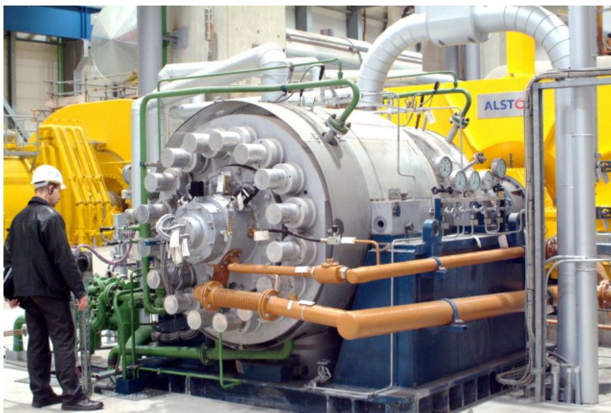
FIGURE 9.2 – Photo d'une pompe du fabricant KSB menant 2 500 t h -1 d'eau à 350 bar dans une centrale à vapeur.
