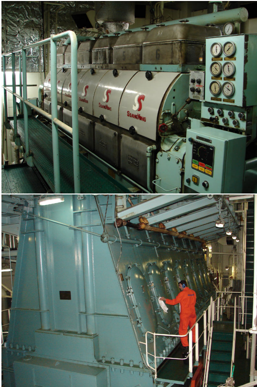
FIGURE 10.32 – Moteurs Diesel six cylindres de 1100 kW électrogène (haut) et sept cylindres de 25 MW propulsif (bas) d'un pétrolier de 290 000 t.
