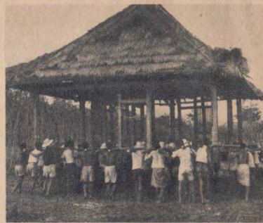
Transport van een ziekenhuisje; op deze wijze werden honderd-dertien huizen verplaatst
