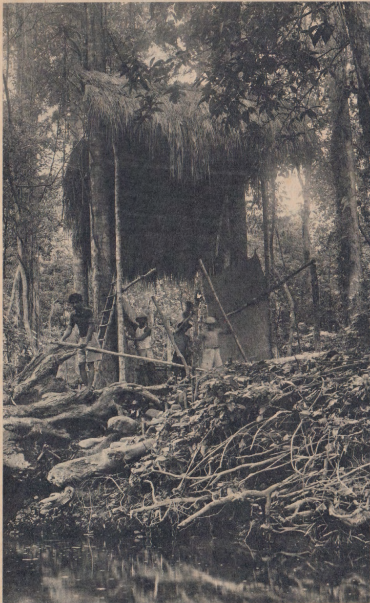
Tijdelijk verblijf van P. Buis, drie meter boven de grond
