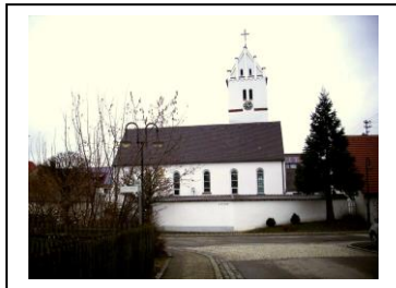
Setzungen-Lageansicht von Süden mit Kirche über Kirchhofmauer-210310
