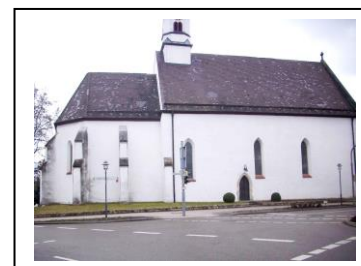
Langenau-Leonhardskirche Ansicht von Nord über Traufseite-210310
