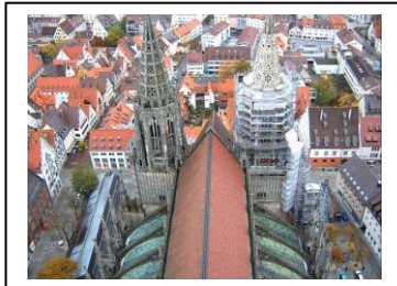
Ulm-Münster Aufstieg 36 level E Langhaus und Ostturm-291006
