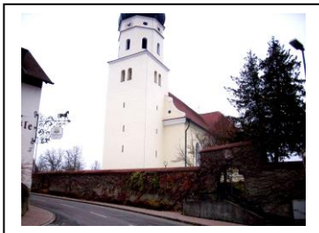
Westerstetten-Kirchturm (mit Schießscharten) und Langhaus über Kirchhofmauer-081109
