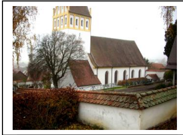
Altheim(Alb)-Kirchturm und Langhaus von Nordost mit Mantelmauerverlauf-081109
