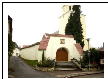
Neenstetten-Kirche mit Tor (ehemaliges Kammertor) und Kirchhofmauer von Ortsseite-081109
