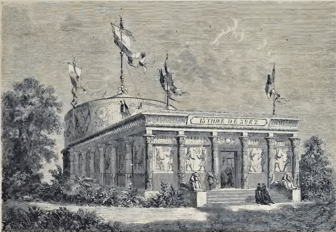
VUE EXTERIEURE DU PAVILLON DE L'ISTHME DE SUEZ. — M. Chapon, architecte. Dessin de M. Lancelot.
