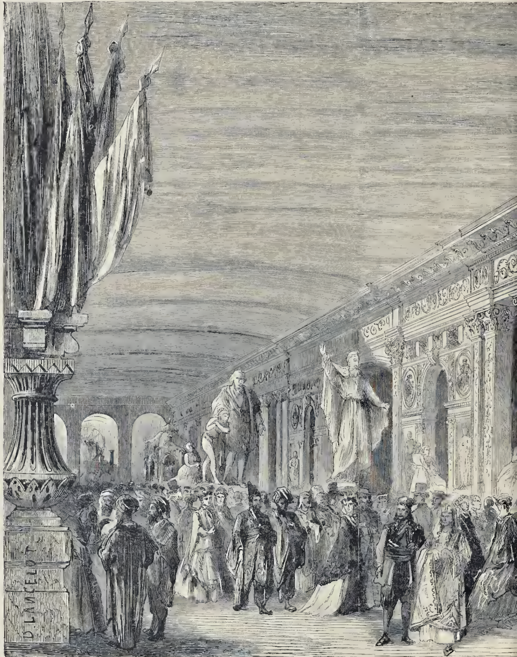
INSTALLATION DE LA GALERIE
