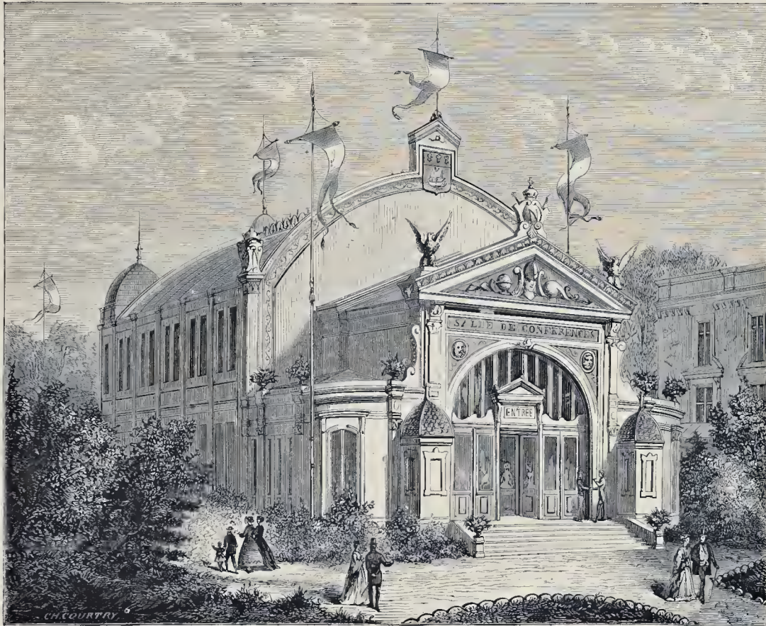
SALLE DES CONFÉRENCES. — Architecte : M. Allard.
