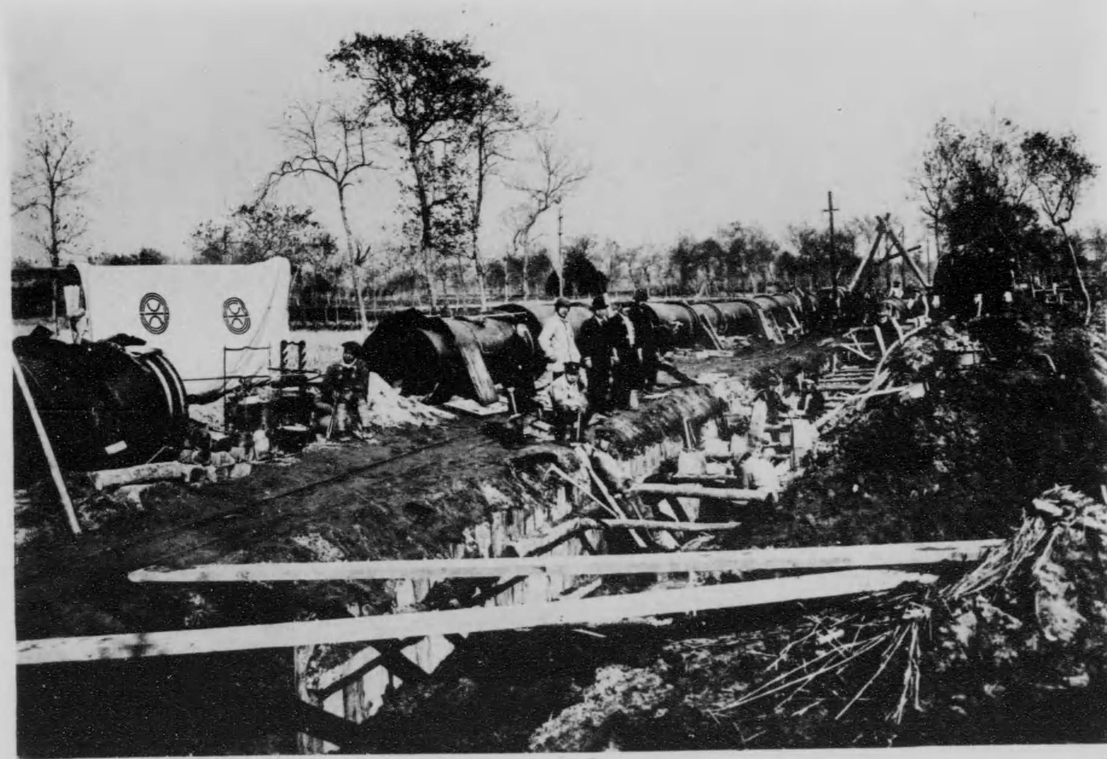
二十四吋送水鐵管布設工事
