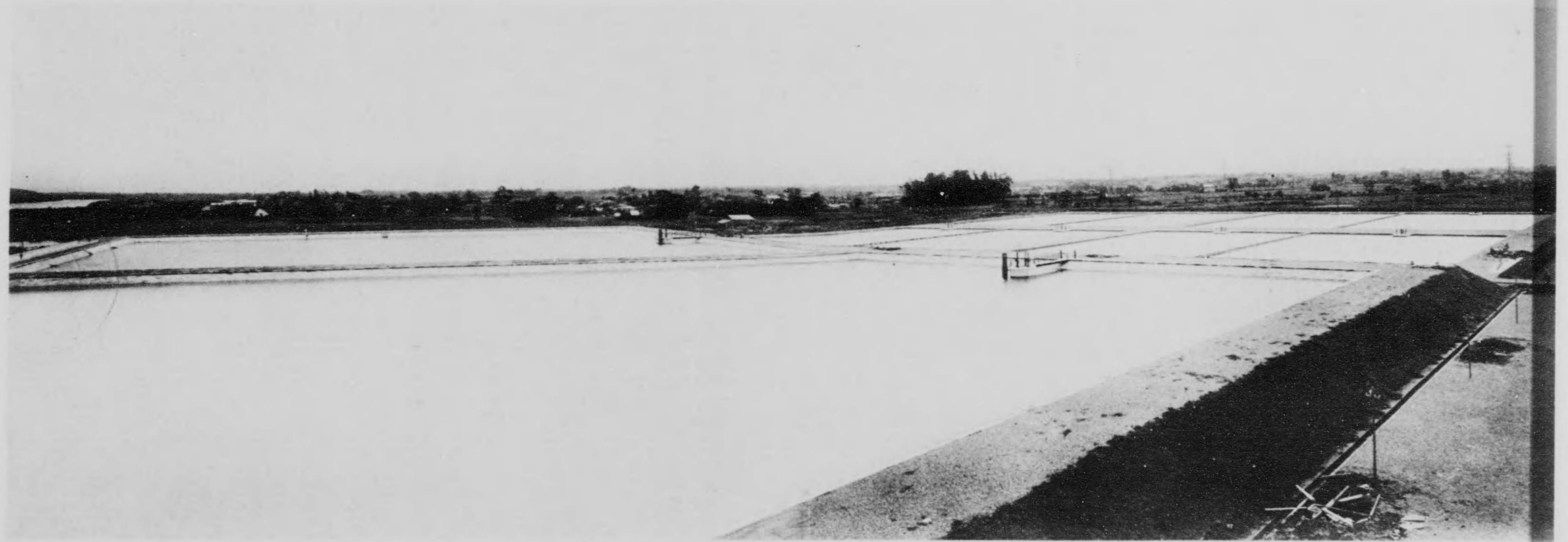
金町浄水場全景
