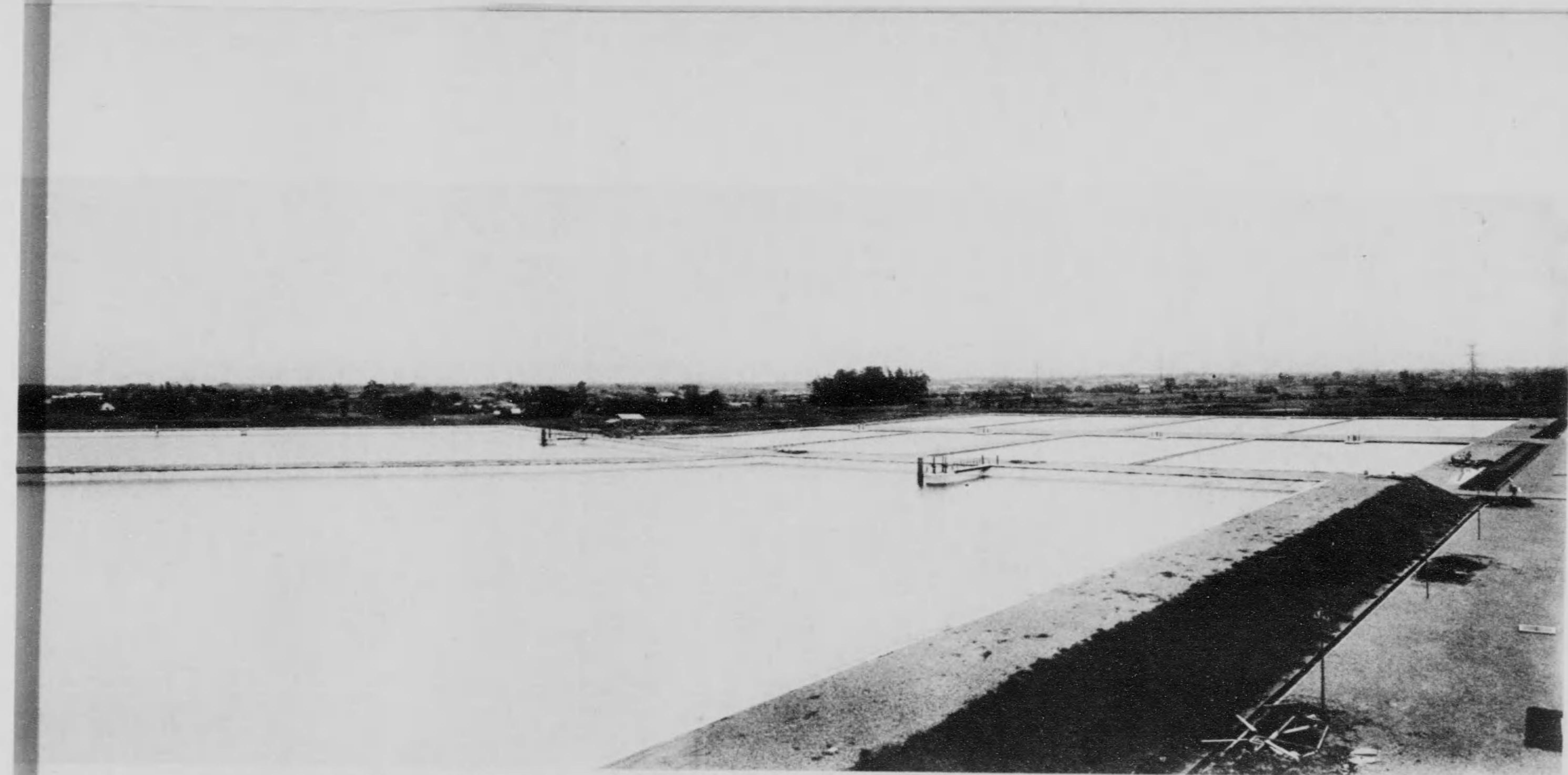
金町浄水場全景
