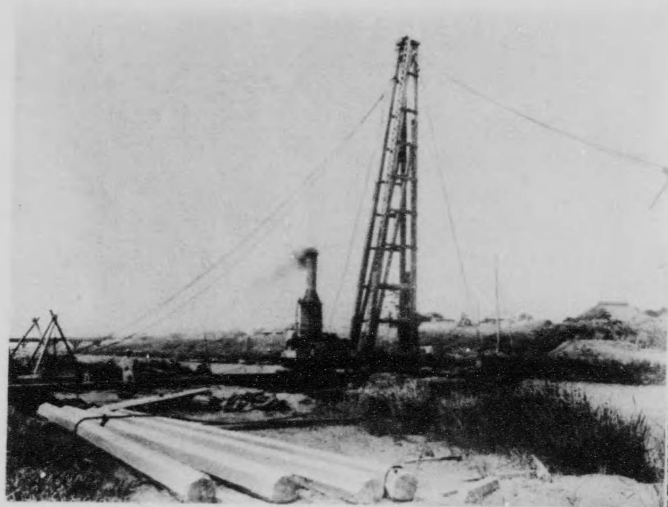
荒川鐵管橋 基礎工事
