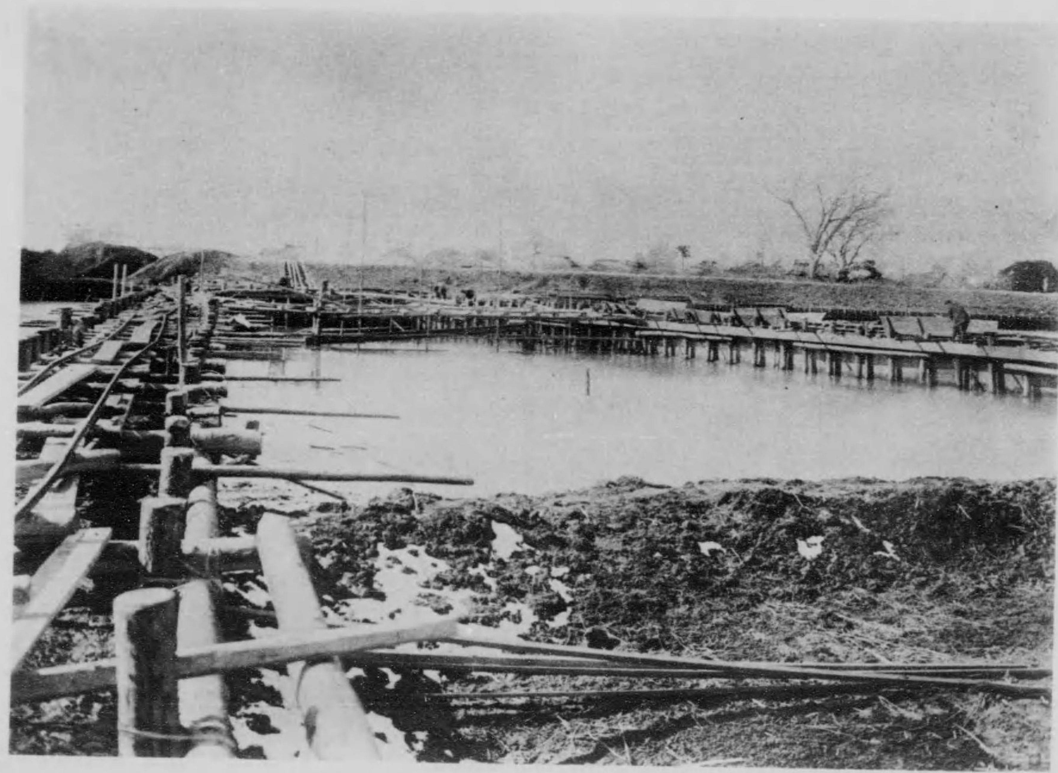
中 事 工 設 架 橋 管 鐵 川 中
