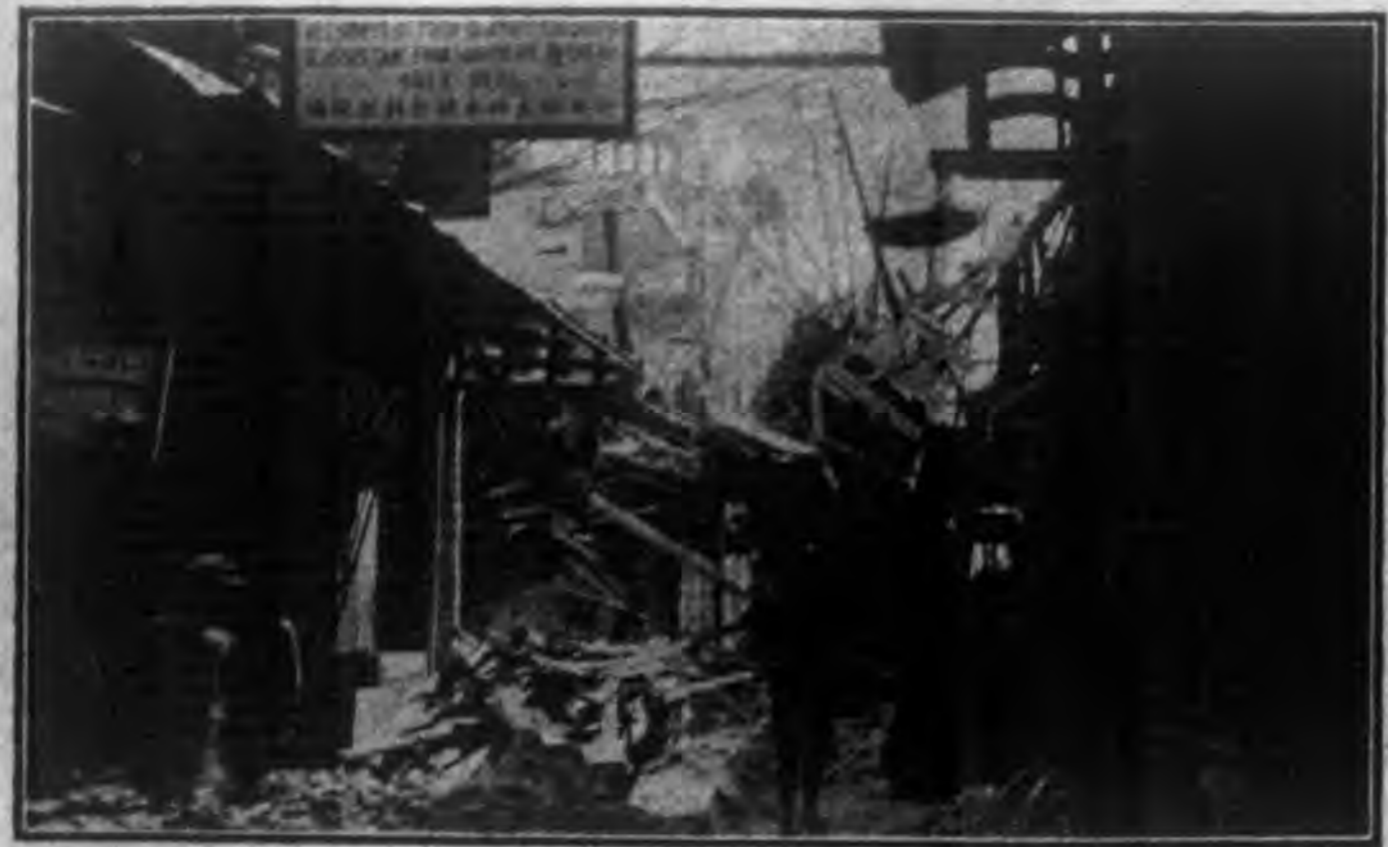
懷安街一帶酒樓戲院倒塌情形
