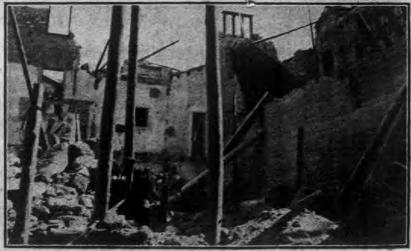
內街一帶房屋倒塌情形
