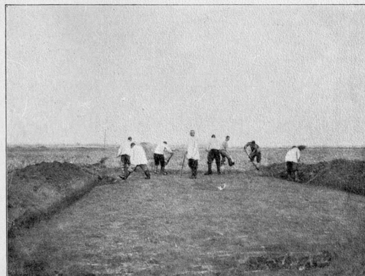
Прокладка колоннаго пути.
