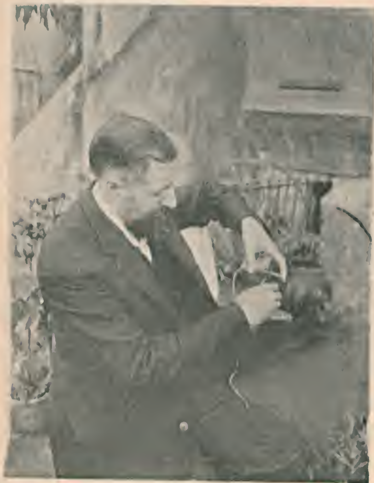
FIG. 1 CRAVAR O DETONADOR E O CORDEL.
