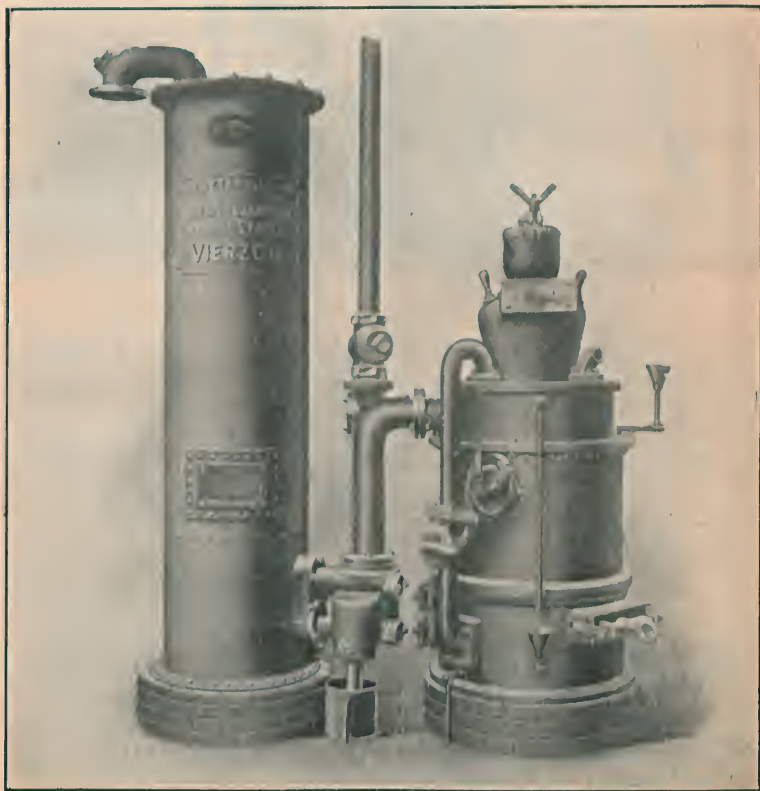
Gazogeeos da Sociedade Franeeza de Material Agrícola e Industrial. — Instalações fixas. — A cavão
