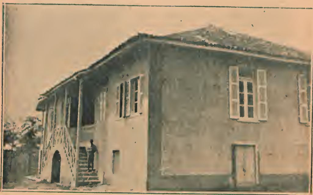
A casa da administração vista de lado, após os reparos que carecia. — Vê-se, á entrada, o Dr. Moncyr Leão.
