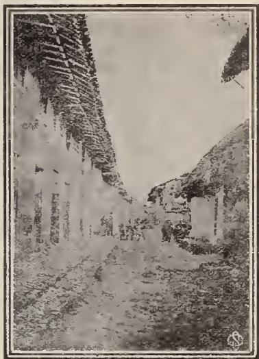
Calle principal de Moyobamba
