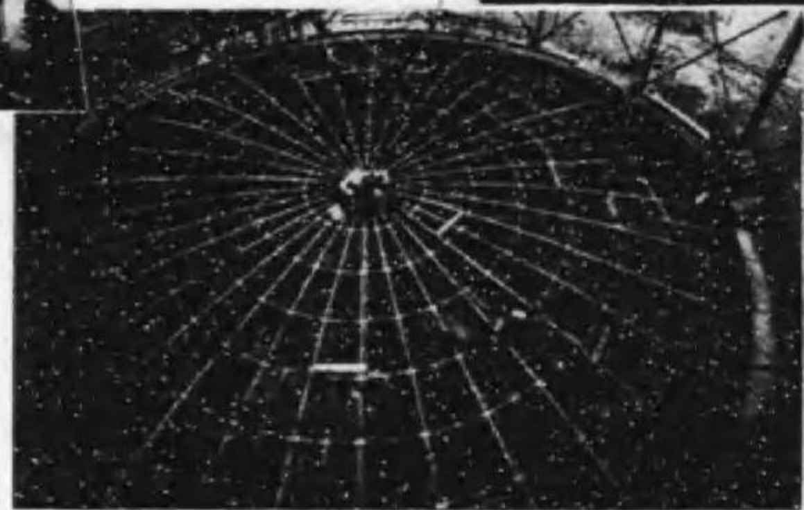
二五、〇〇〇立方米瓦斯貯蔵槽
