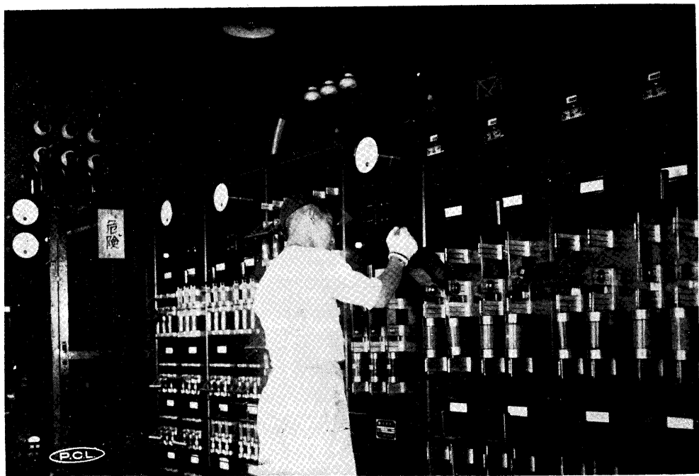
P. C. L. 影片公司變電所之內觀
