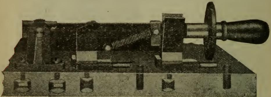
FIG. 44. A QUICK-BREAK KNIFE SWITCH.
