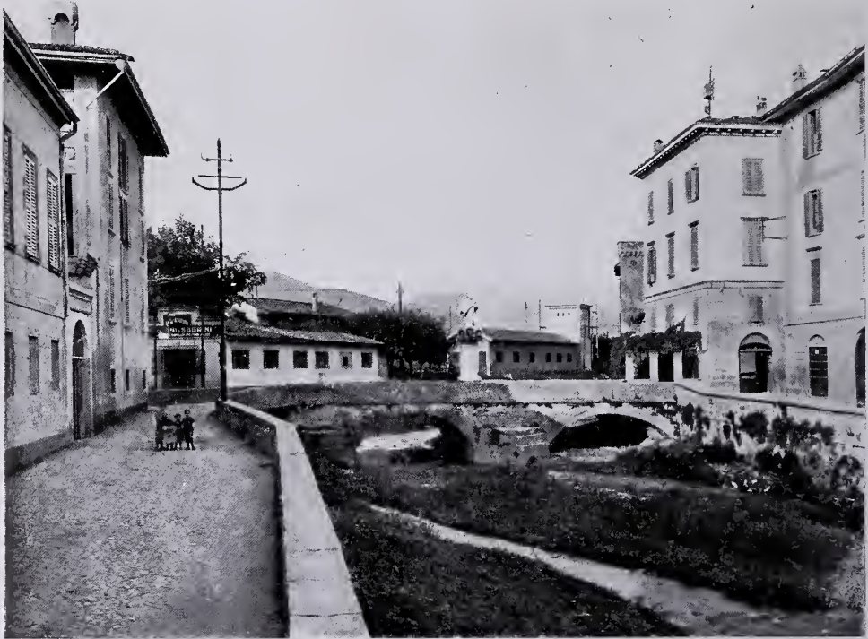
PIANA CITTÀ — BORGHI PALAZZO — PONTE SUL TORRENTE MORLA.
