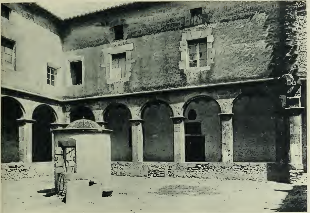
CLAUSTRO DE LOS DOMINICOS DE ULLDECONA.—1900
