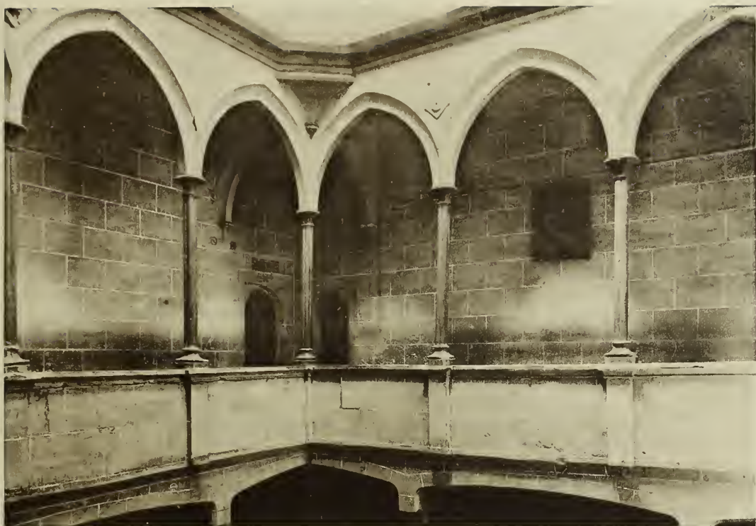
GALERÍA ALTA DEL CLAUSTRO DE LOS DOMINICOS DE SOLSONA.—1897
