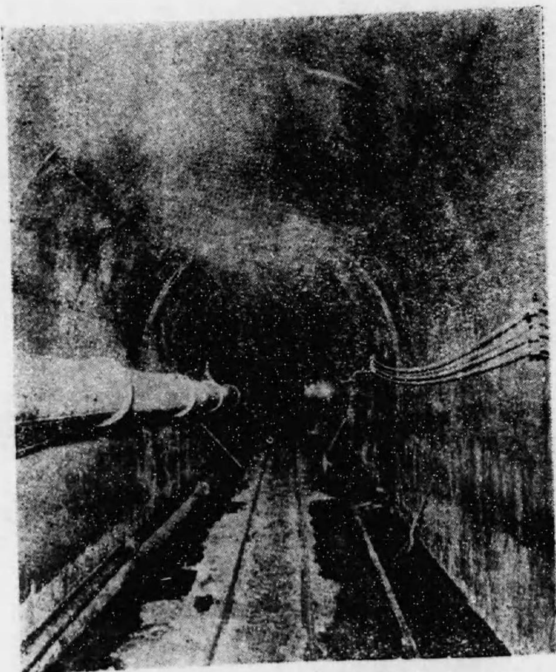
第百六十二圖 水道のトンネル
