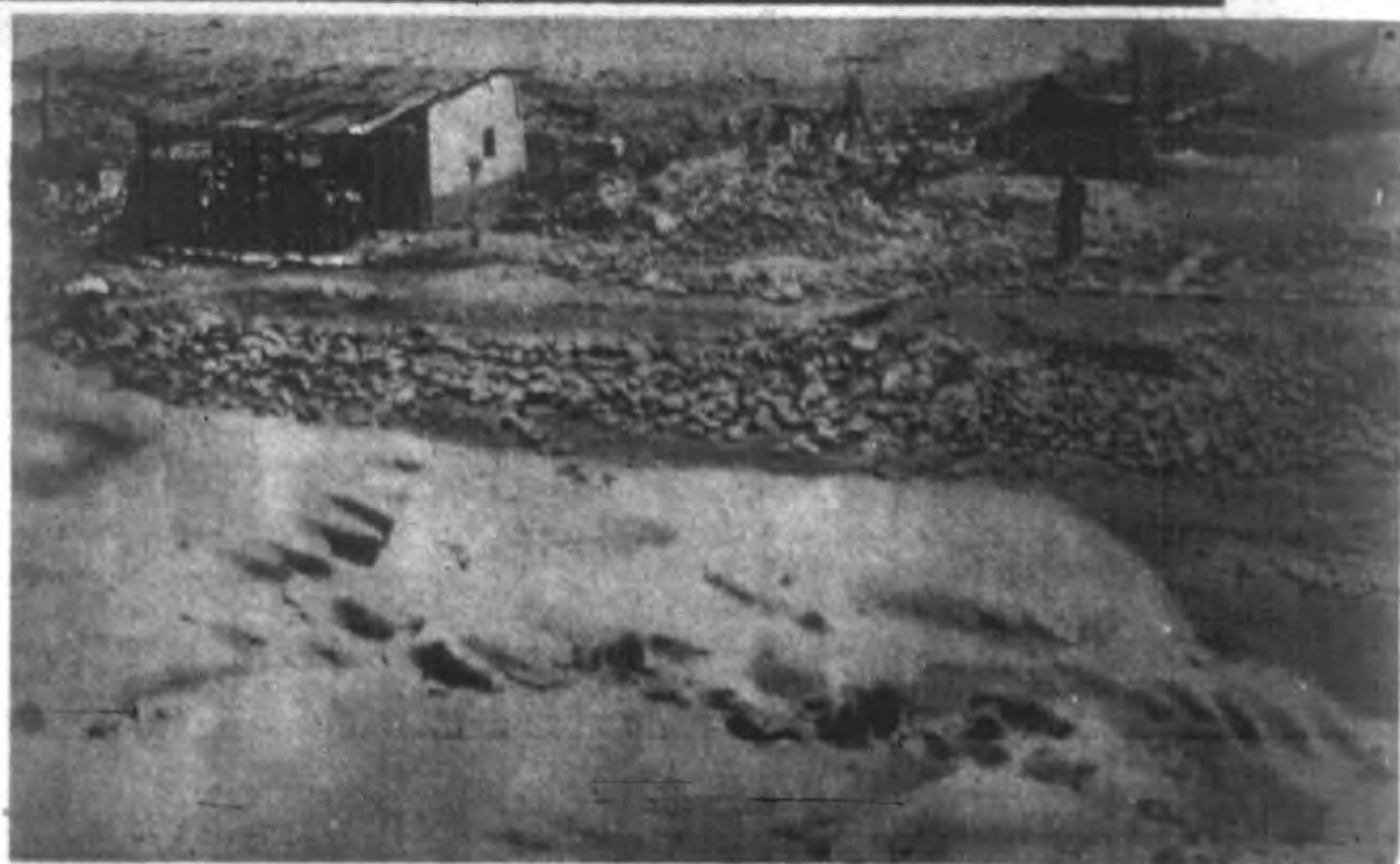
武威縣公署受震坍塌之情形
