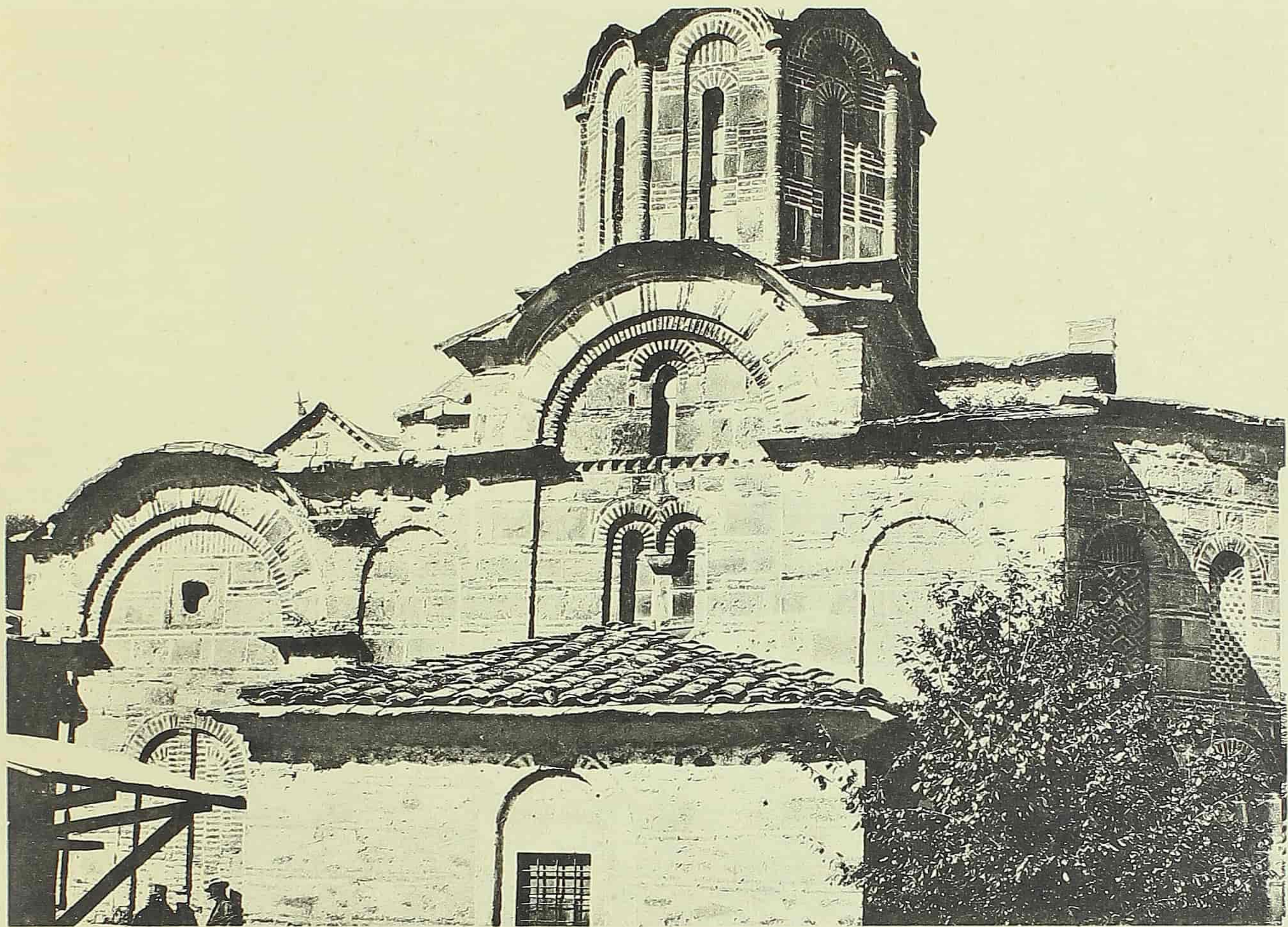
Слика 10. Детаљ јужне фасаде.
