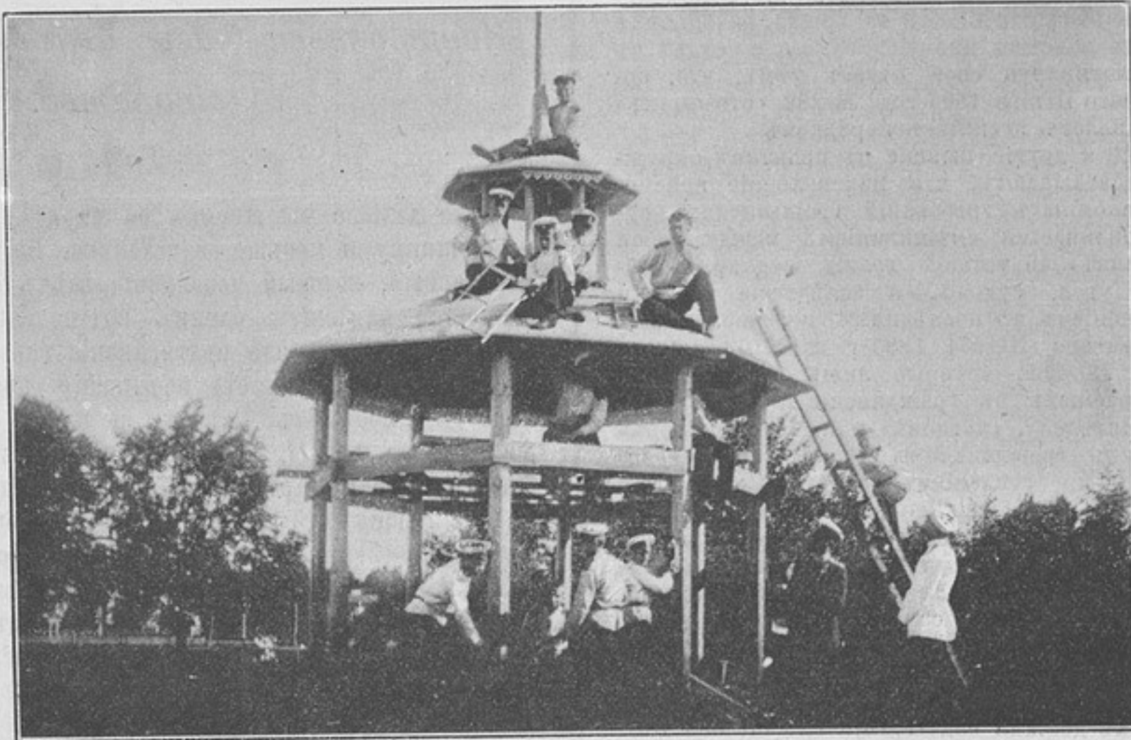
Постройка деревянной бесѣдки.
