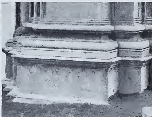
Fig. 38. — Base di un pilastro nel Duomo di Pavia.
