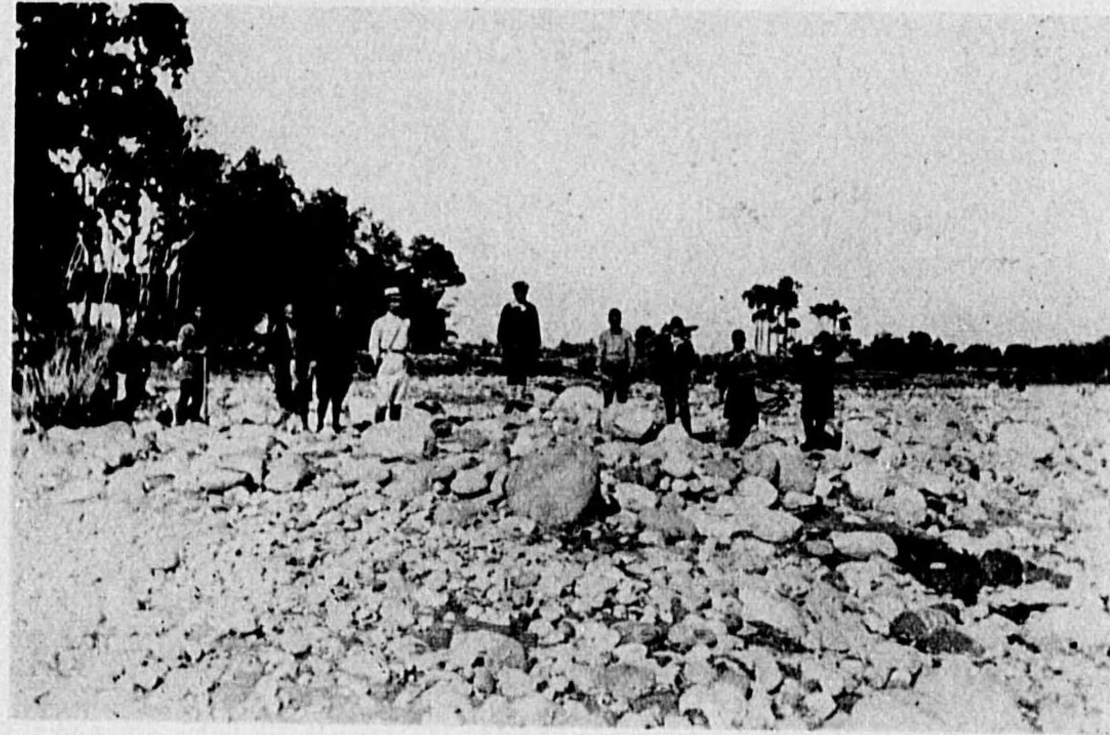
山政安岸左川寺願常年三正大 地害被ノ裏林櫛殿シ壊破防堤
