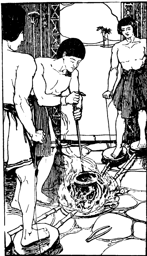
埃及人鑄金的情形，用皮囊鼓風，用竹管導之入爐。
