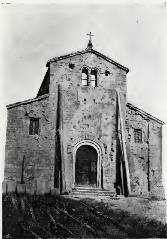
Facciata nello stato attuale.
