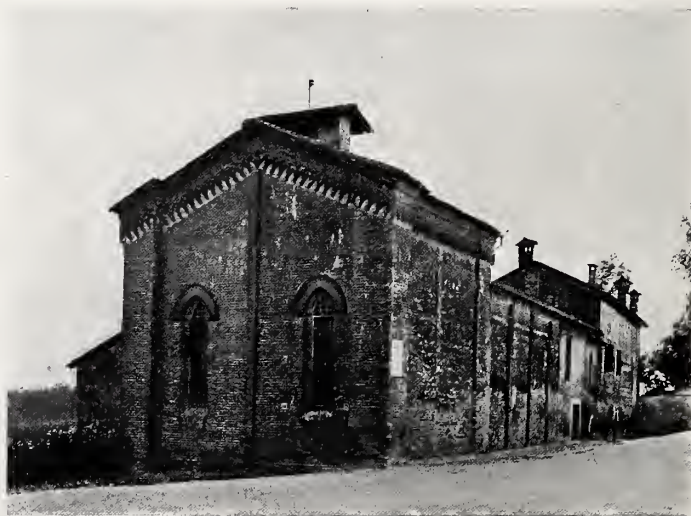
(Fig. 2) - Chiesa e Precettoria di S. Antonio. Prospetti lungo la via Emilia (nord).
