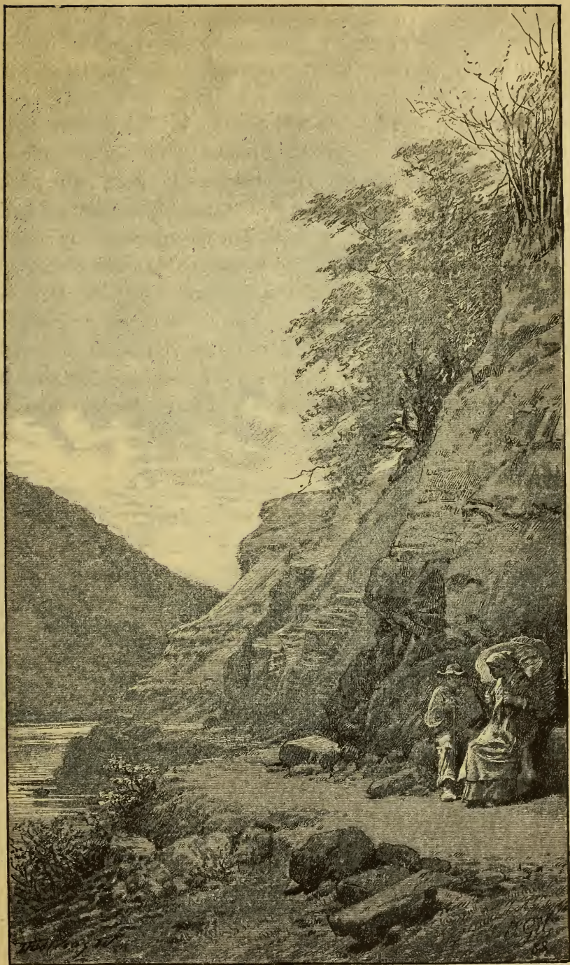
HOZ DE ENTRAMPAS-MESTAS. CAMINO NUEVO (EN CONSTRUCCIÓN) PARA EL VALLE DE PAS
