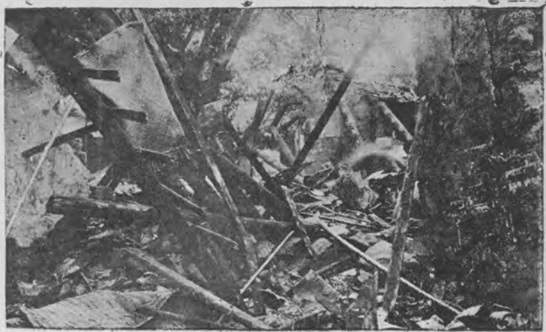
▶ 海康縣城屬前街貧民住屋 倒塌情形
