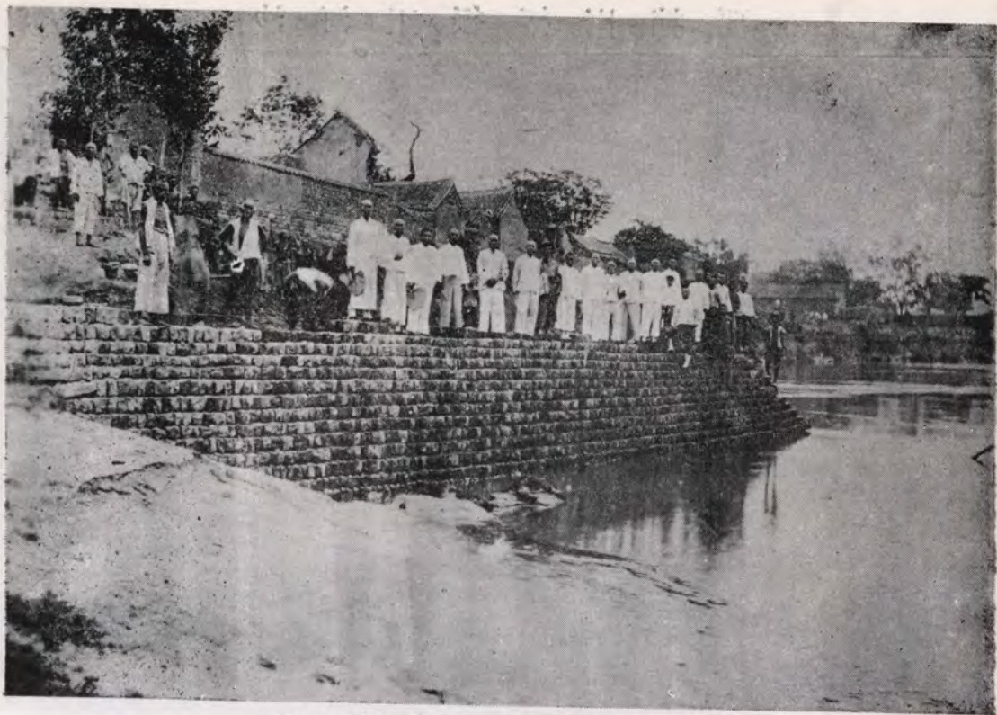
第三段建築襄城三里溝石壩竣工
