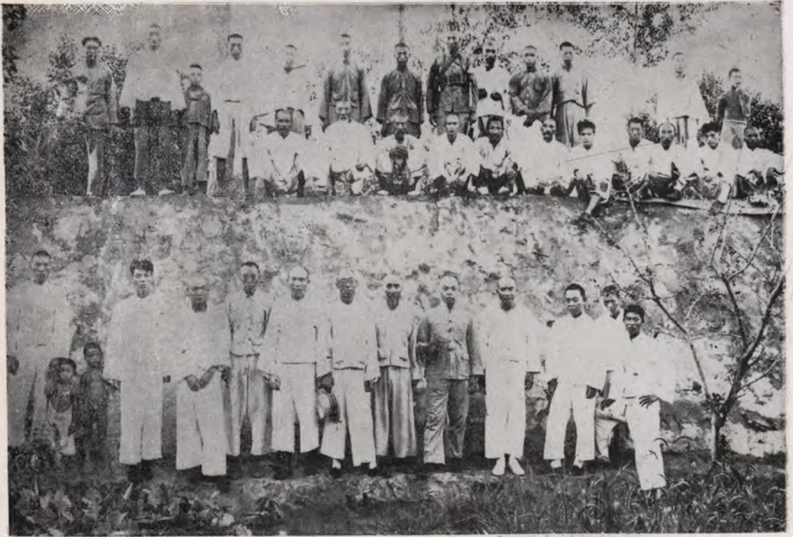
第二段修築偃師洛河南岸堤竣工
