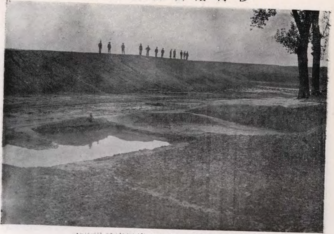
第四段北舞渡東關外南岸新築月堤工
