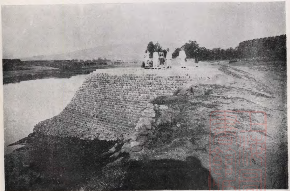
第三段建築襄城西門外大字壩竣工
