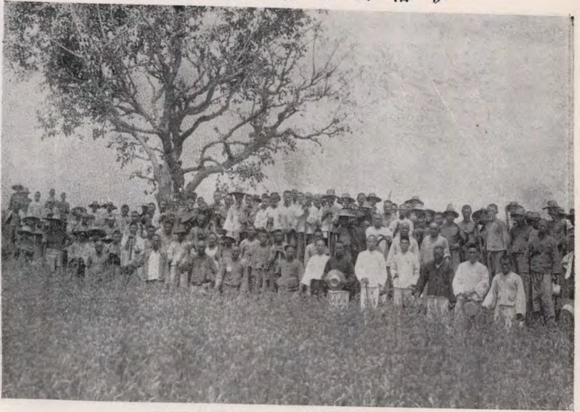
第二段修築優境伊河南岸堤開工
