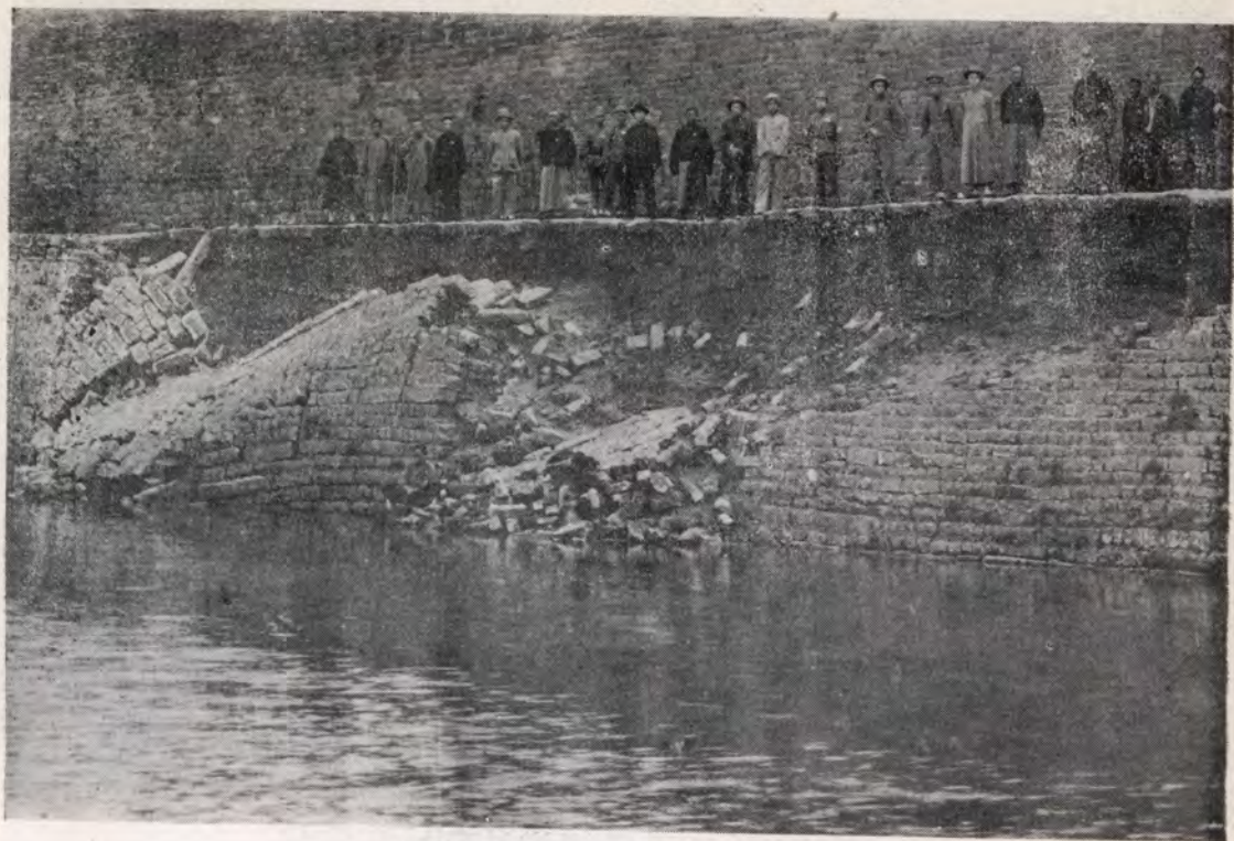
河南襄城縣南門外石堤坍塌情形之一
