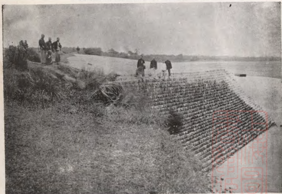
第一段汝墳橋石壩竣工
