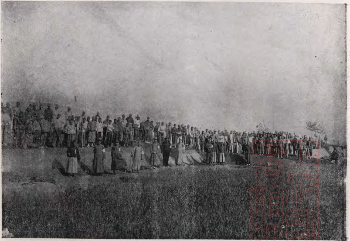
第四段鞏縣蘇村堤開工
