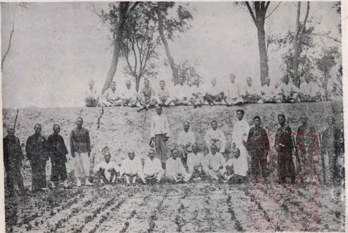
第二段修築偃師洛河北岸堤竣工
