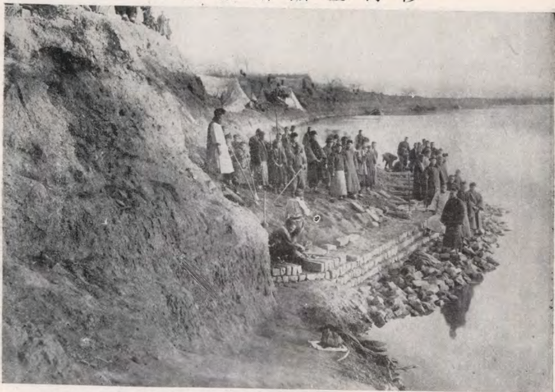
第二階段修築霍堰鎮第二大道字壩暨石護岸工程進行狀況
