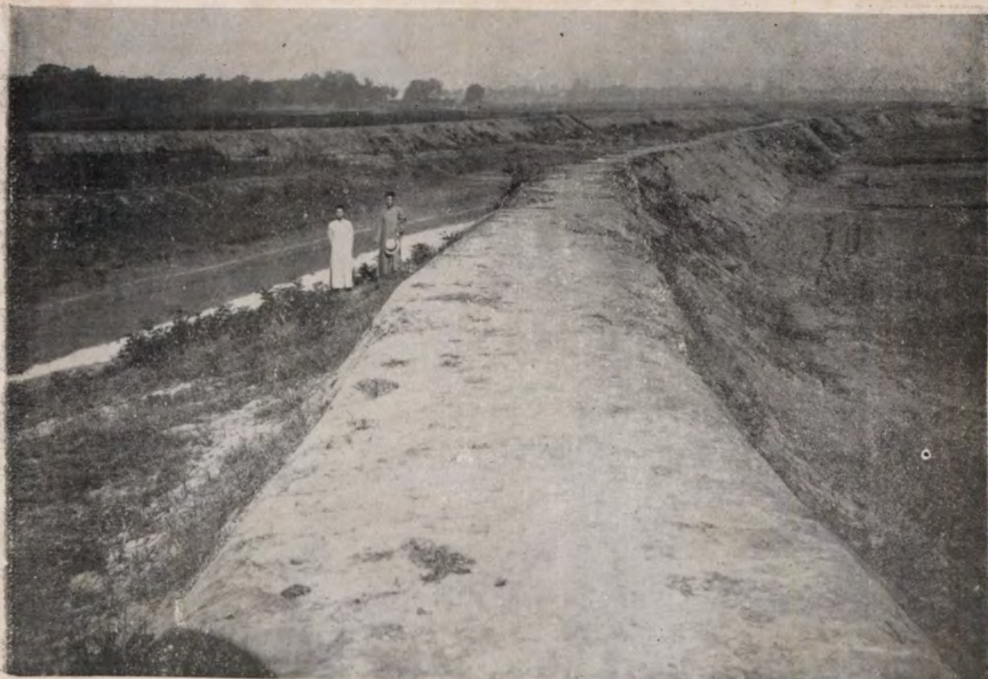
修築乾河土堤
