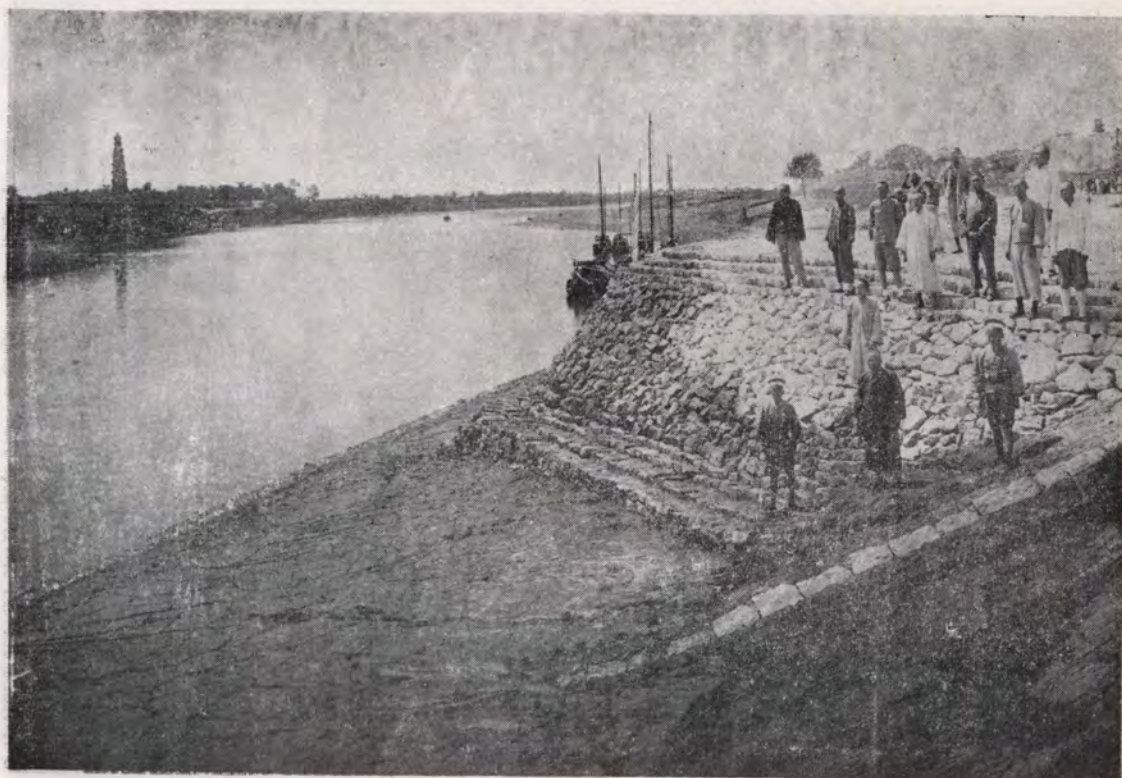
第 六 段 修 築 道 遙 汝 河 石 壩 竣 工 之 一
