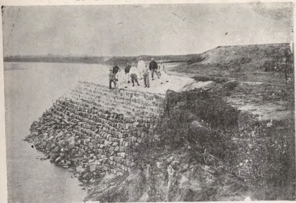
第一段臥羊山石壩竣工
