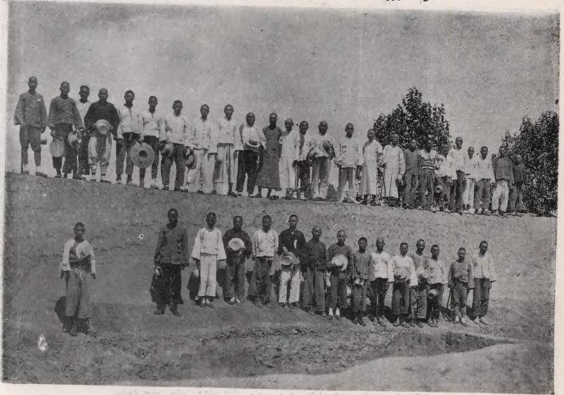
第四段修築鞏縣蘇村堤竣工
