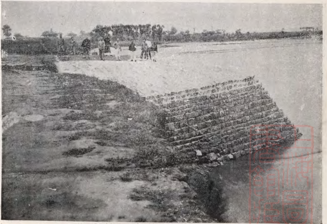
第一段十里舖石壩竣工
