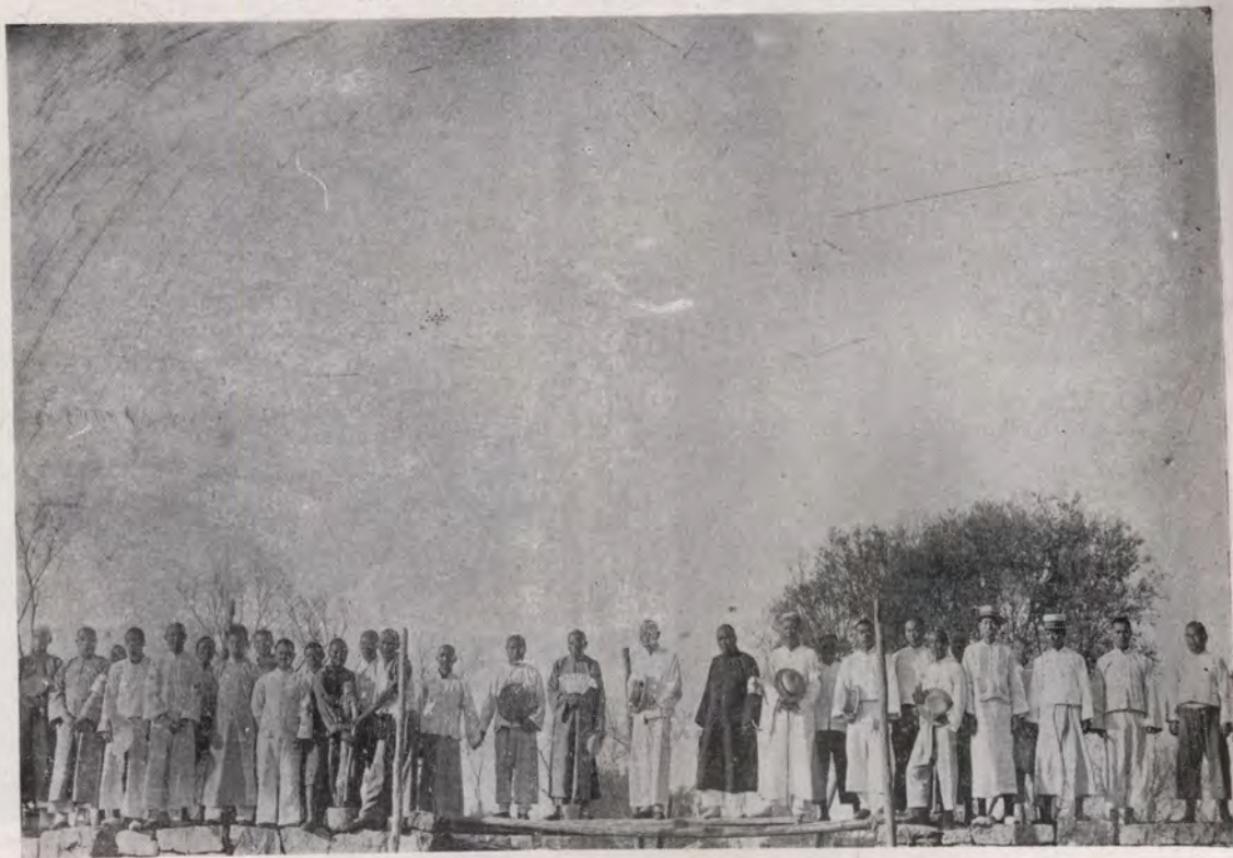
第二段修築師南城門開工
