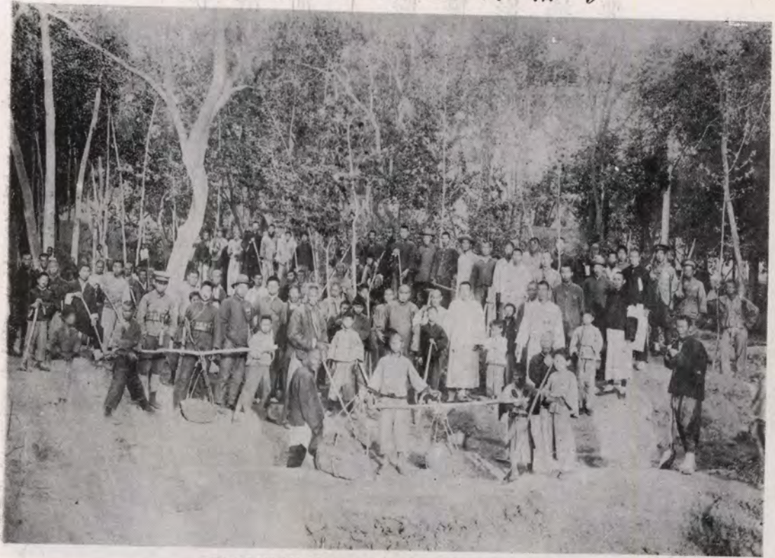
第二段修築僱工境洛河北岸堤開工
