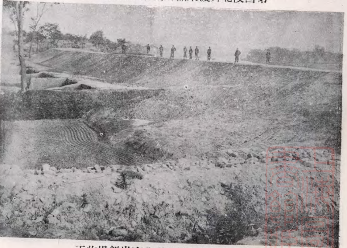
第四段北舞渡寒外東北岸新築堤工
