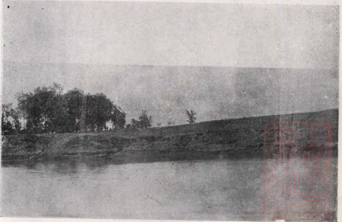
第五段修築西門外土堤完工
