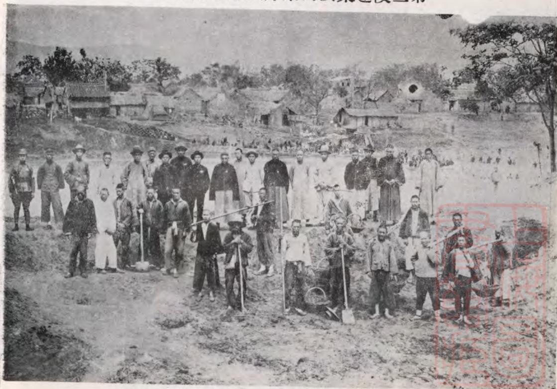
第三段修築汝河東岸汪督祠決口工作情況
