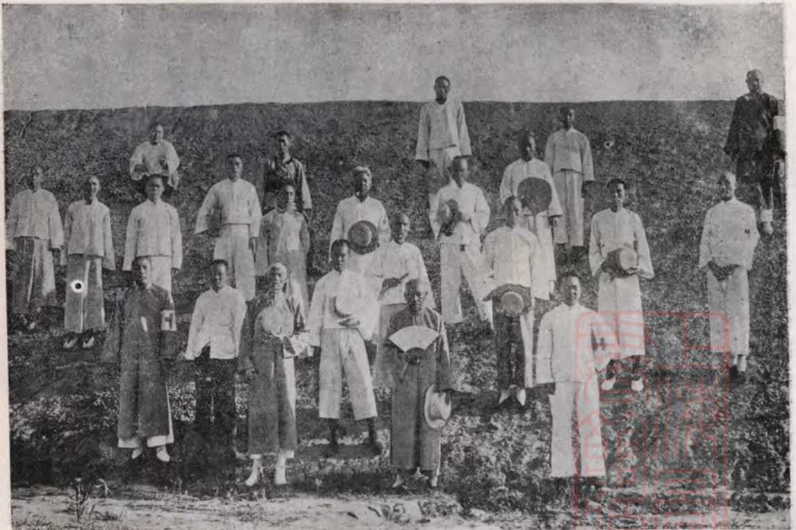
第二段修築偃師護城堤竣工
