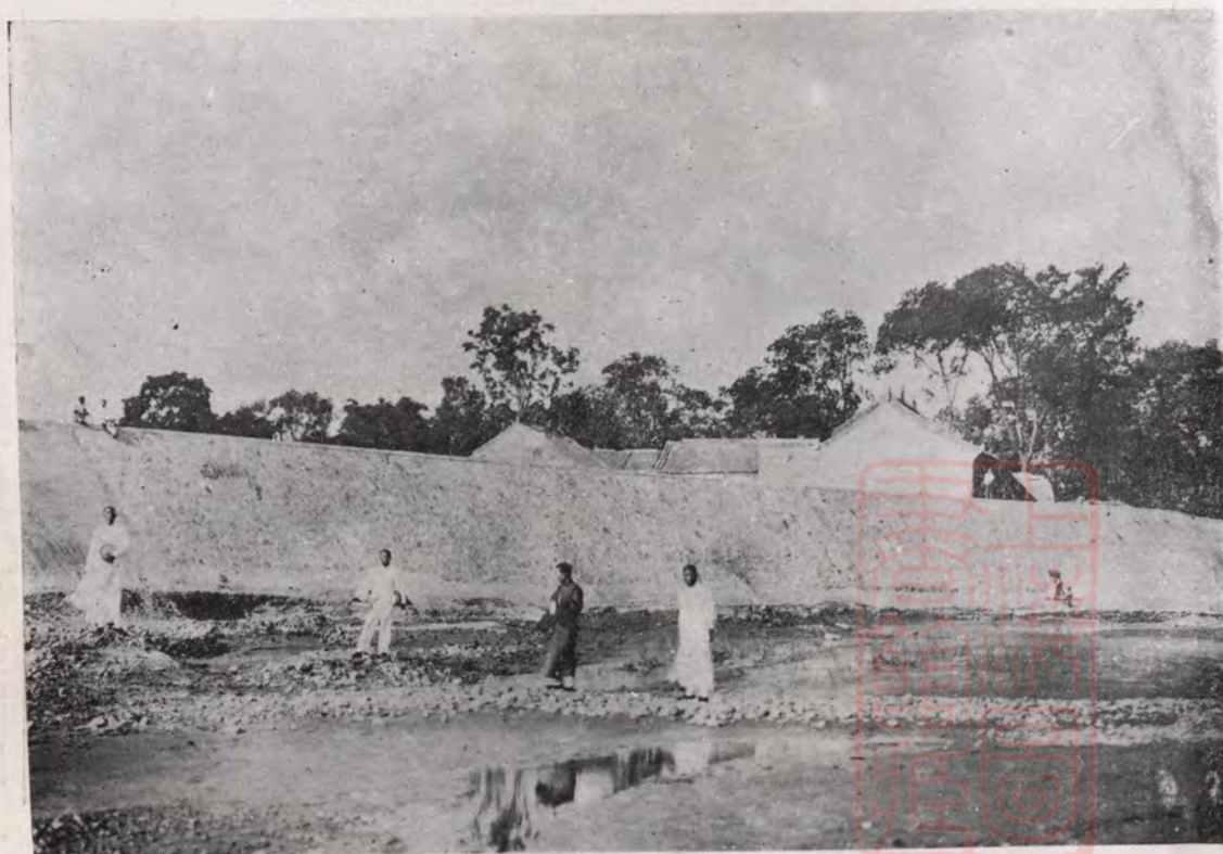
洛陽南關洛河堤第三壩竣工
