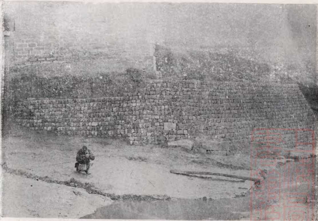
第四段修築北舞渡北岸小字壩工程進行狀況
