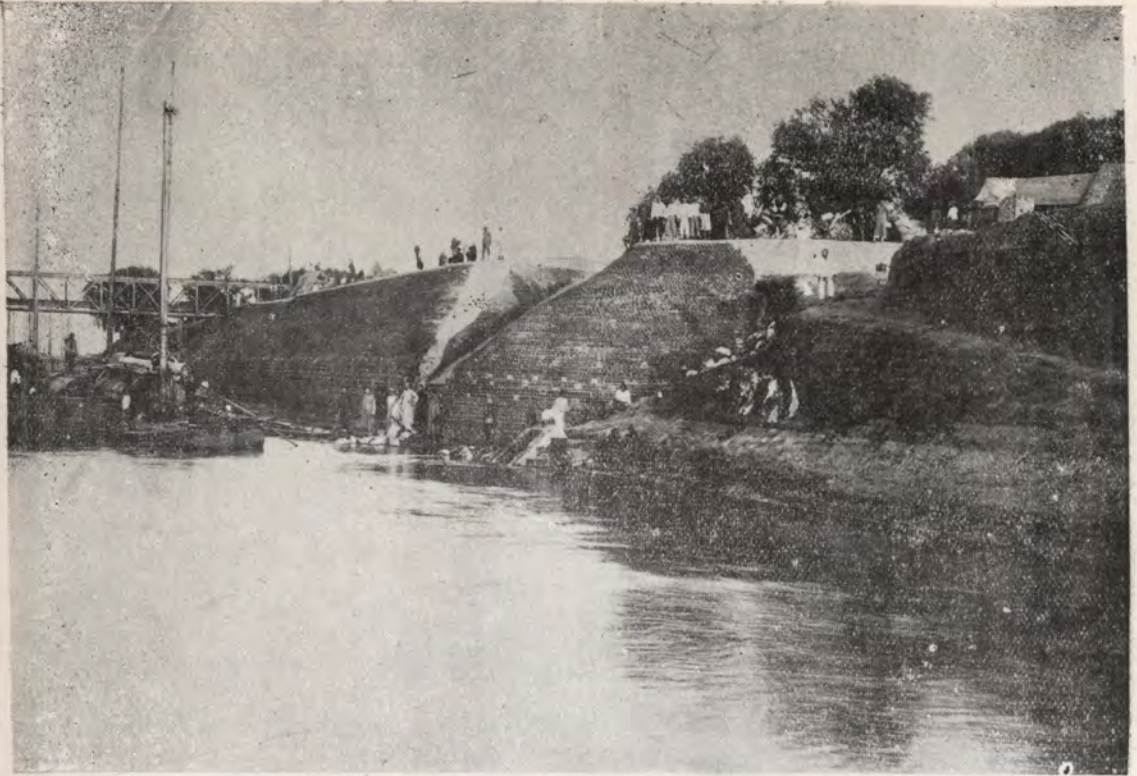
修築鄭城車站洋橋頭石堤工竣工之一
