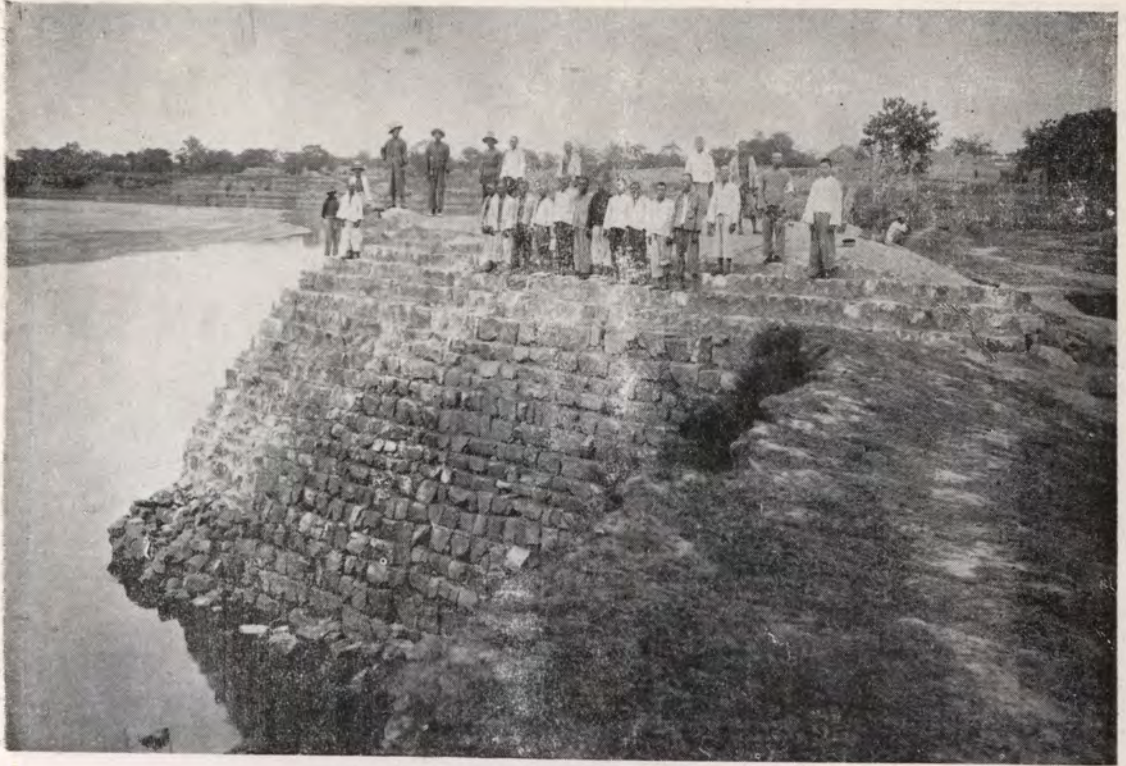
第一段葉縣石壩竣工
