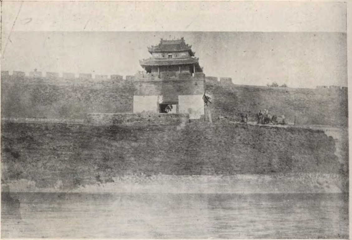
修 築 鄆 城 西 關 堤 工 第 八 節 老 龍 頭 下 完 工
