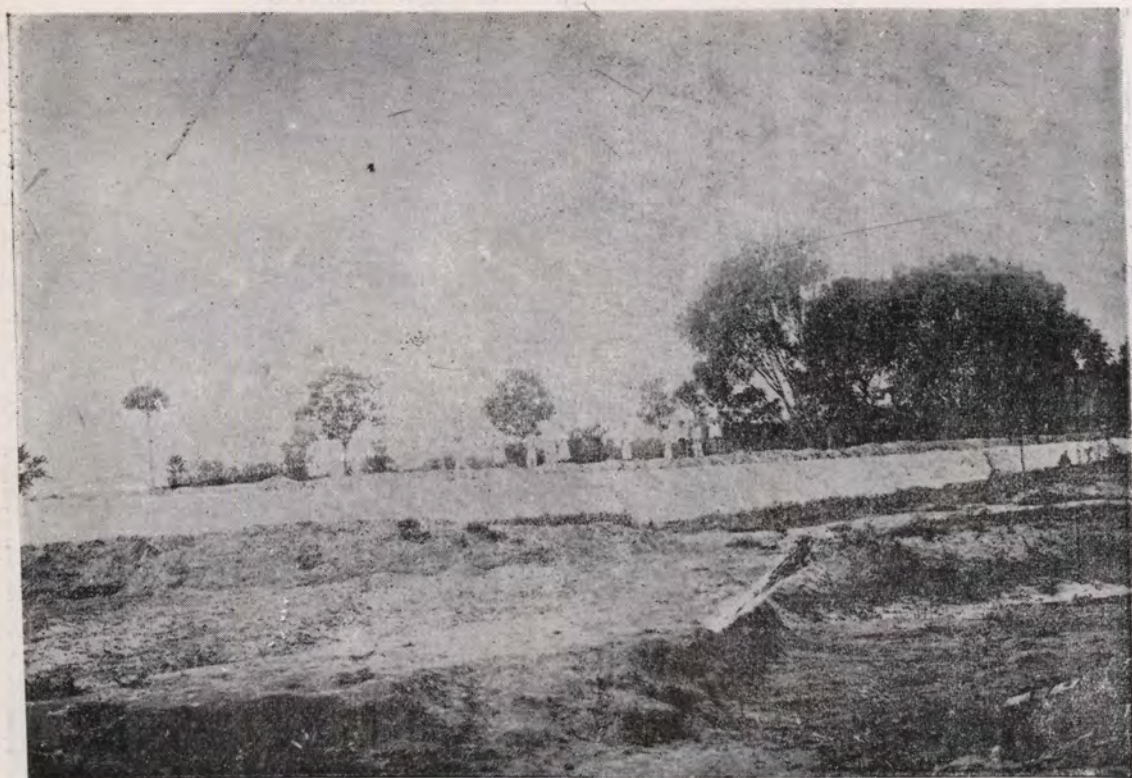
第三段鞏縣倉西堤工竣
