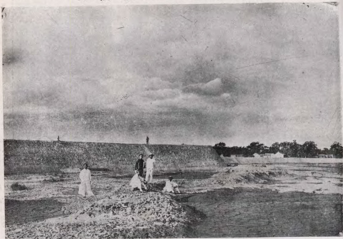
洛陽南關洛河堤第二壩竣工
