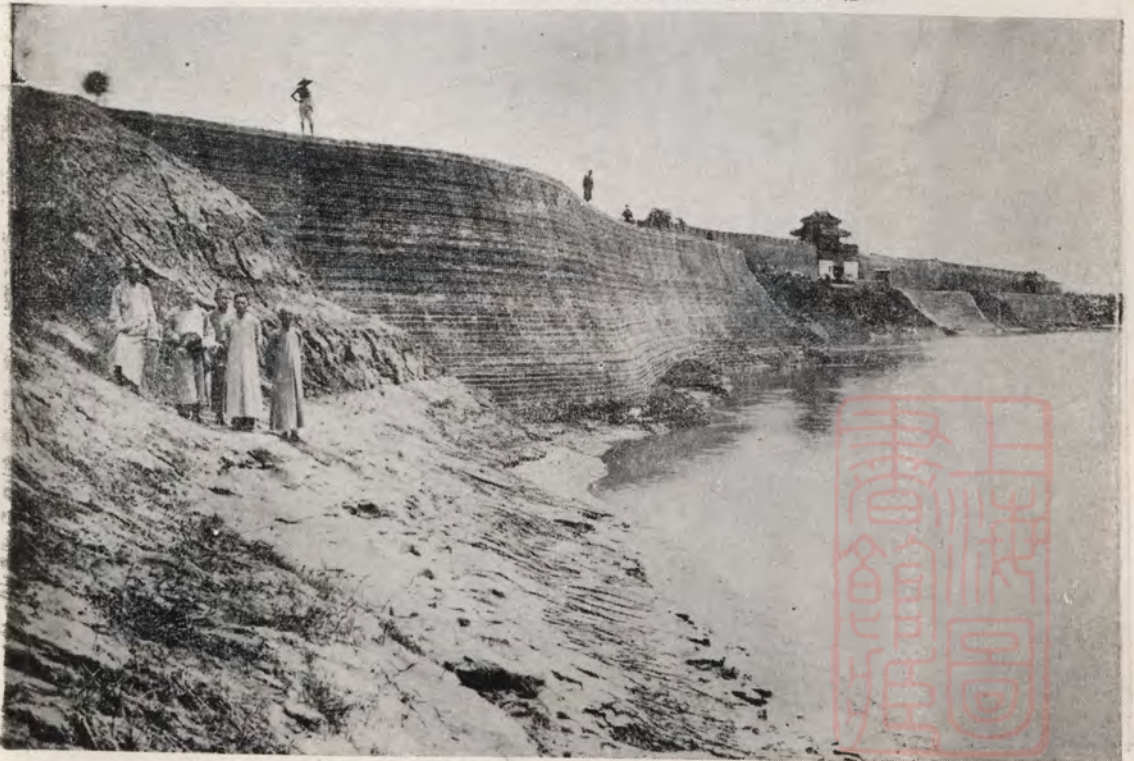
修築鄆城西城門外石堤工程竣之一
