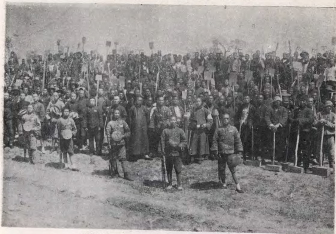
第三段建築汝河東岸黃潭口堤開工
