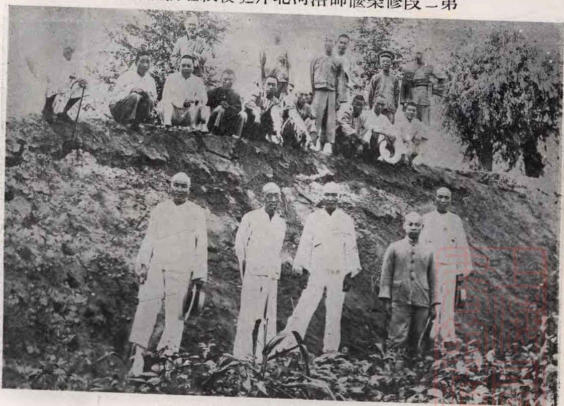
第二段修築優師伊河北岸堤竣工
