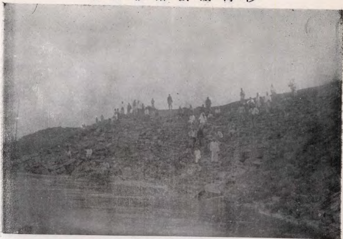
第四段修築古城石堤竣工
