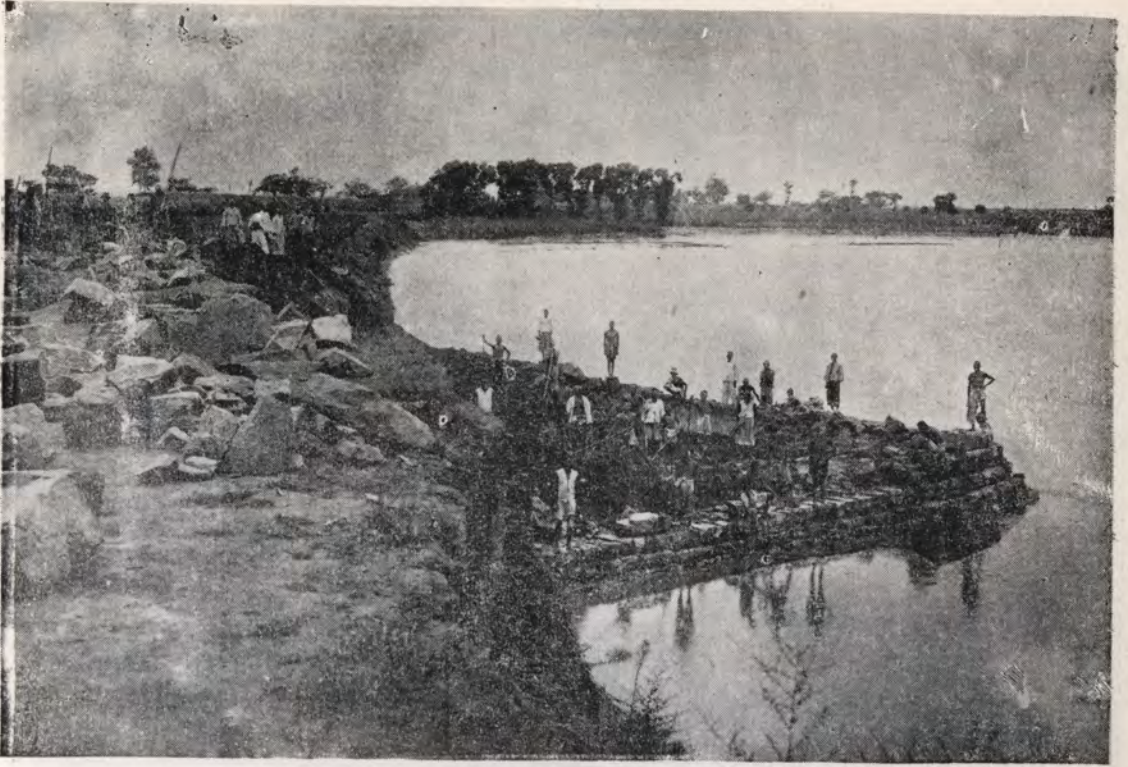
第一段十里舖第一壩開工
