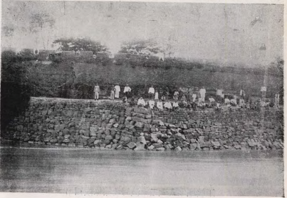
第四段修築北舞渡大人工字壩竣工
