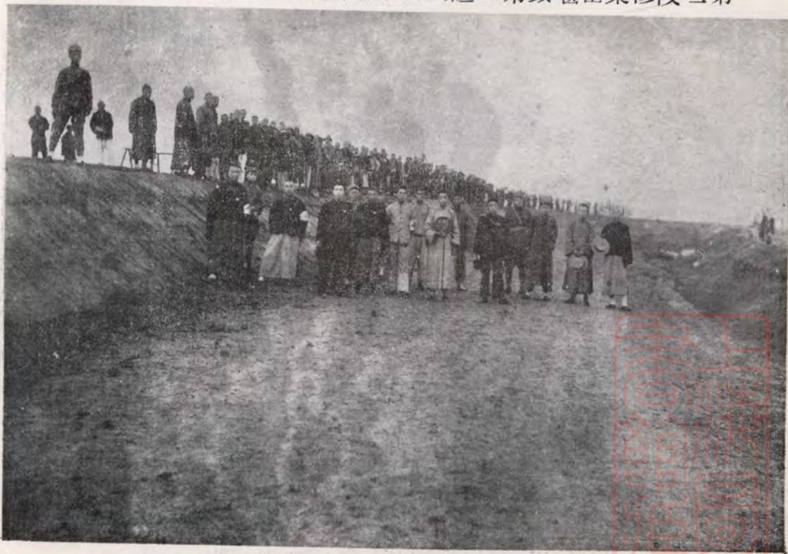
第三階段建設汝河北岸白華潭月堤竣工
