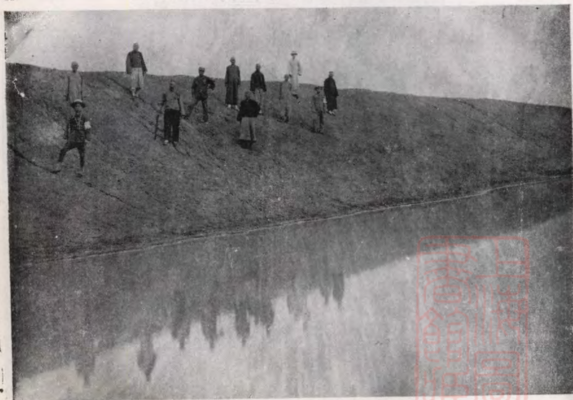
第 四 段 鎮 渡 口 西 北 新 堤 收 工
