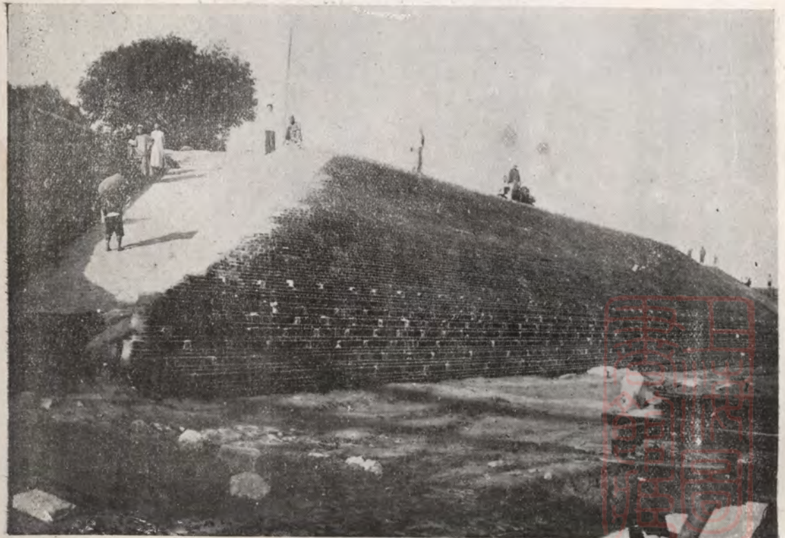
修築鄭城車站洋橋頭石堤工竣工之二
