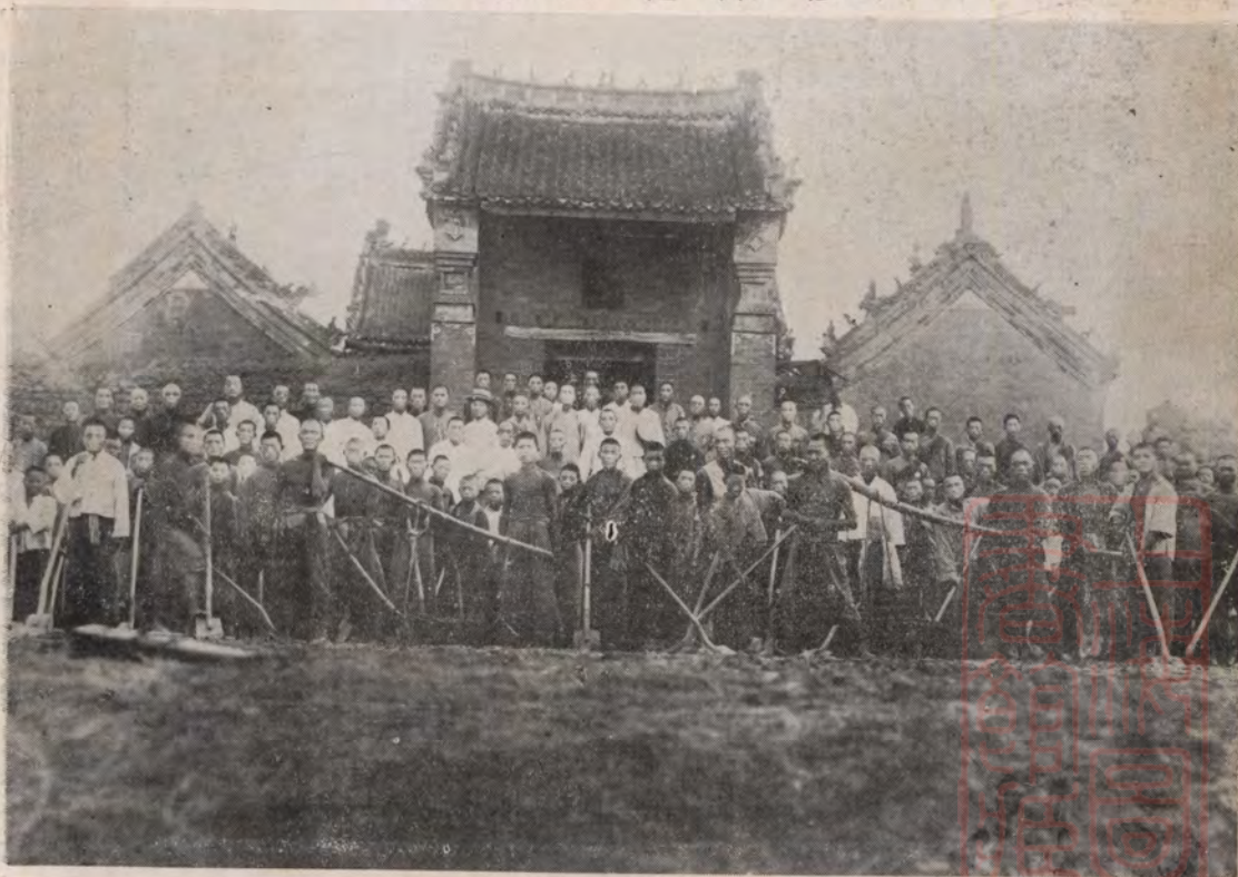
鄆城縣乾河工振第一階段譚嘴工程
