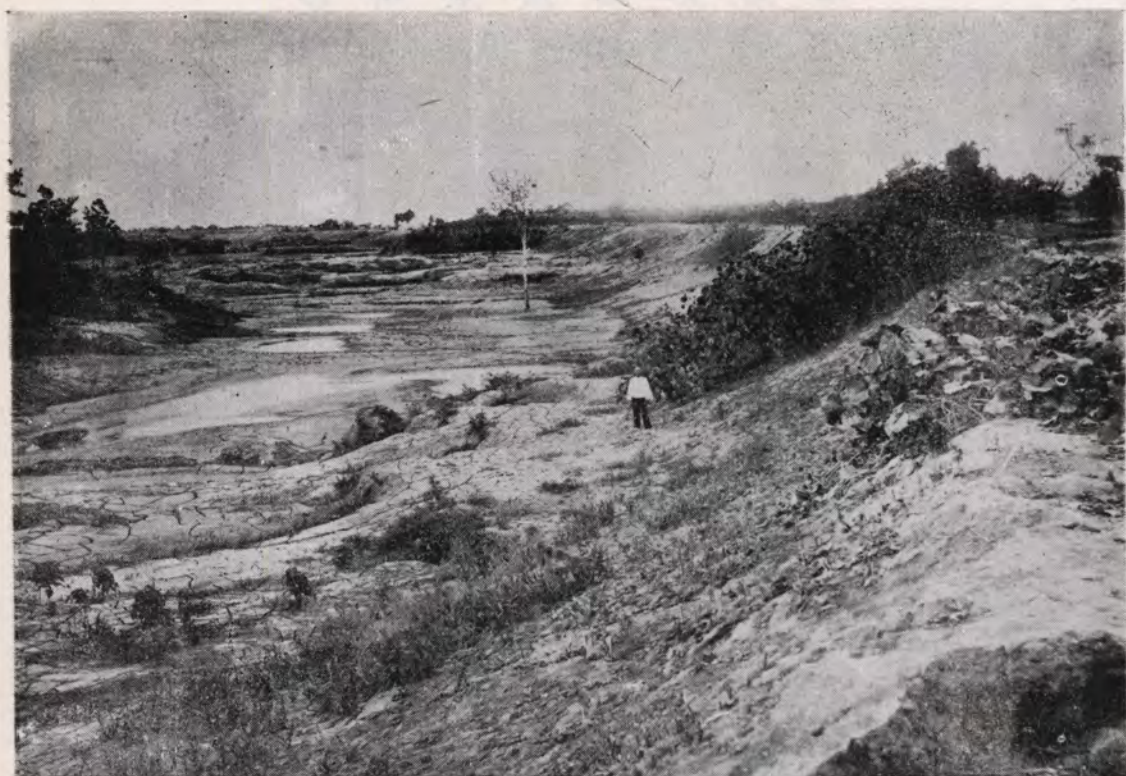
第五段陳村汝河決口處修築土堤竣工
