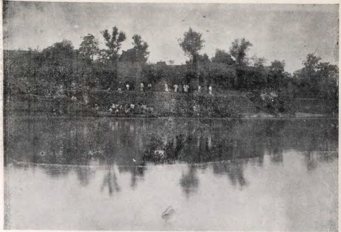
第二段汝河東岸集鎮築石壩暨護岸工程竣工
