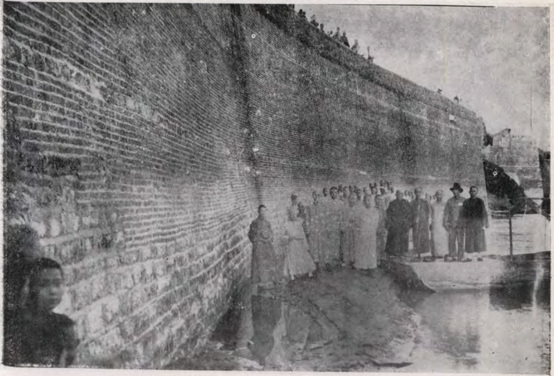
第七段修築北口第一節石堤竣工
