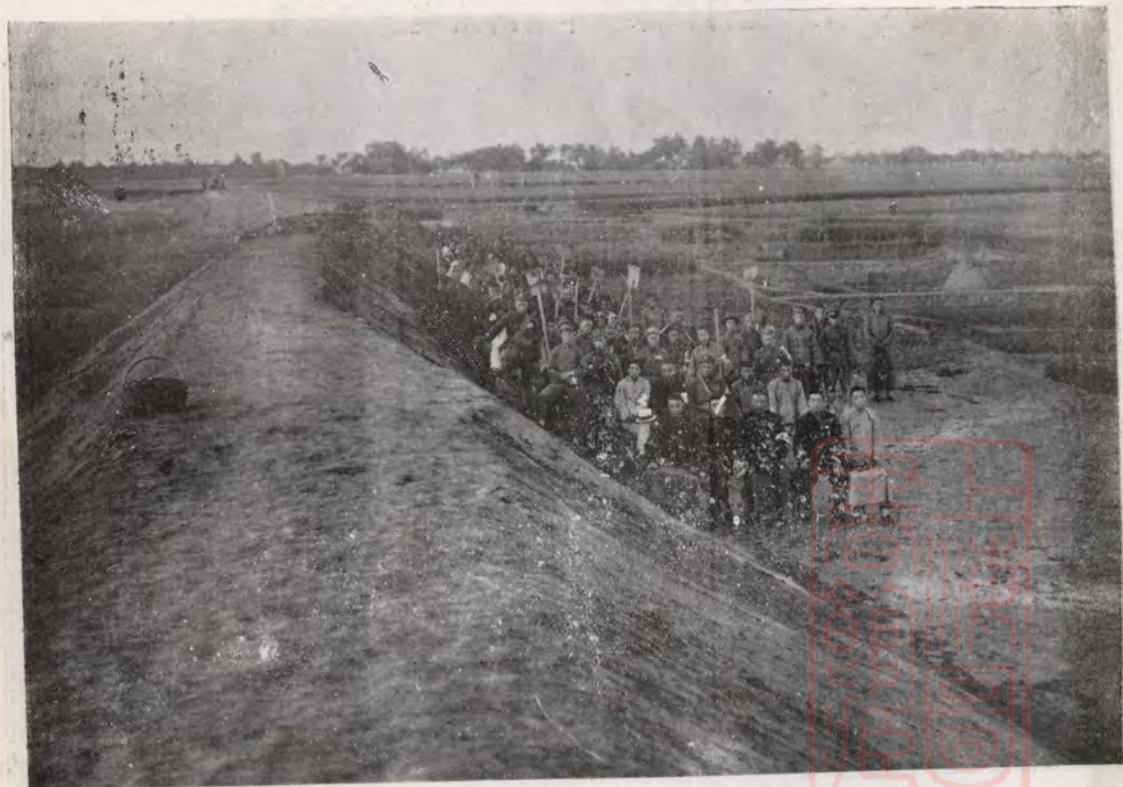
第三段建設汝河東岸店南張月堤竣工
