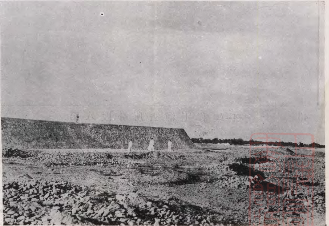
洛陽南關河堤第一壩竣工
