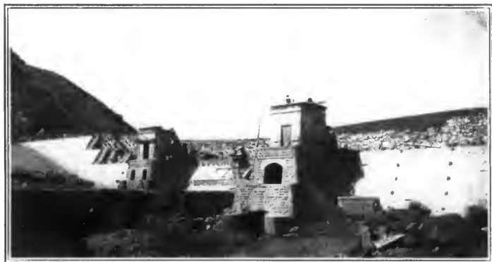
LA PRESA DAM, SAN LUIS POTOSI, MEXICO.
