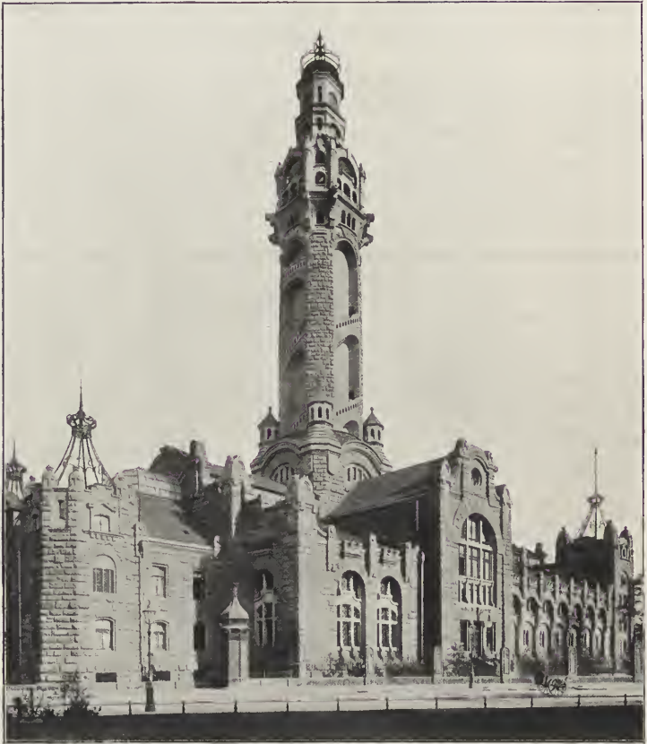
Abb. 7. Lossow & Viehweger, Fernheizwerk in Dresden.
