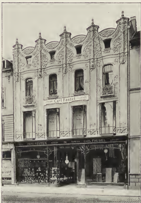
Abb. 36. G. Wehling, Wohn- und Geschäftshaus in Düsseldorf.
