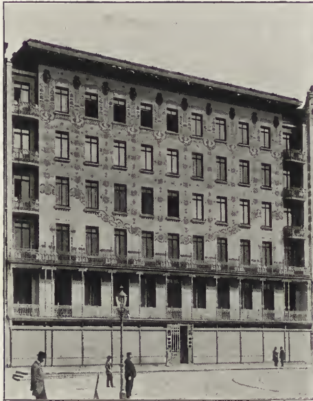
Abb. 34. Otto Wagner, Fassade eines Wohnhauses in Wien.
