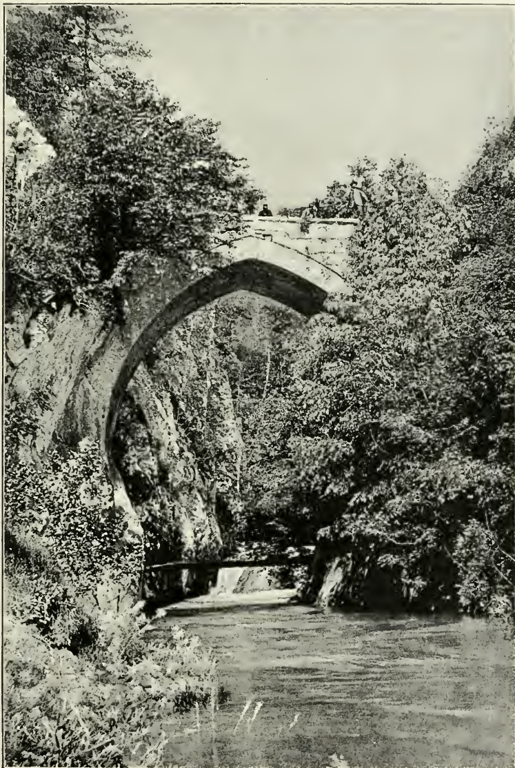
Alte Brücke über die Žepa.
