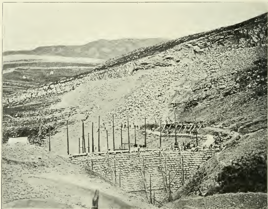
Arbeiten an der Kline bei Gacko.
