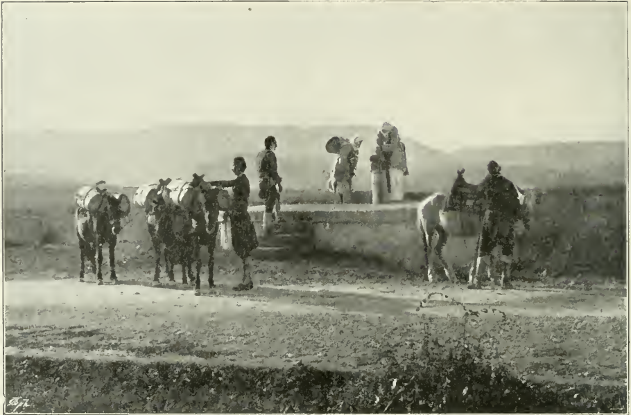
Cisterne in der Hercegovina.
