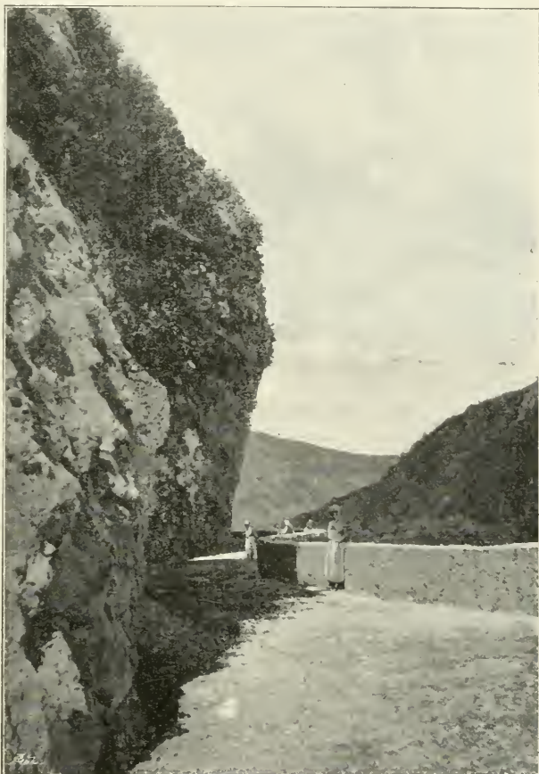
Ausgesprengte Strasse bei Divić zwischen Srebrenica und Zwornik.
