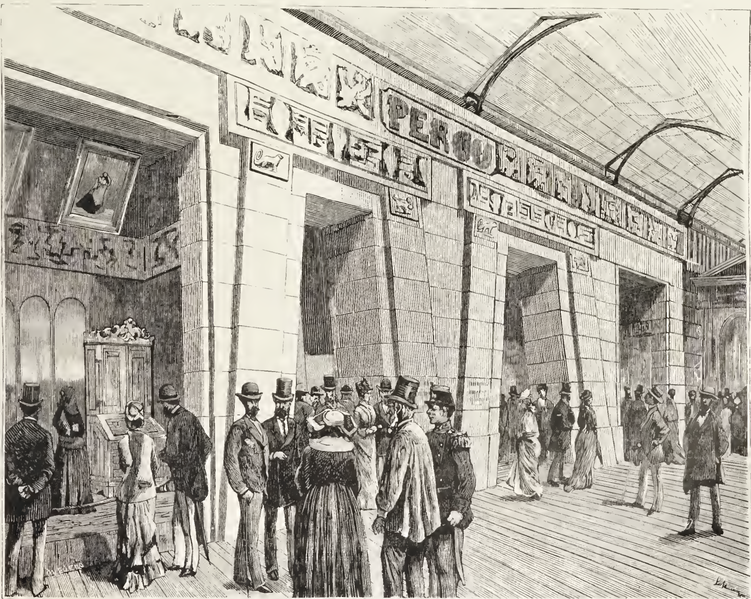
FACCIATA DELLA SEZIONE DEL PERÙ NEL PADIGLIONE DELL'AMERICA CENTRALE E MERIDIONALE.
