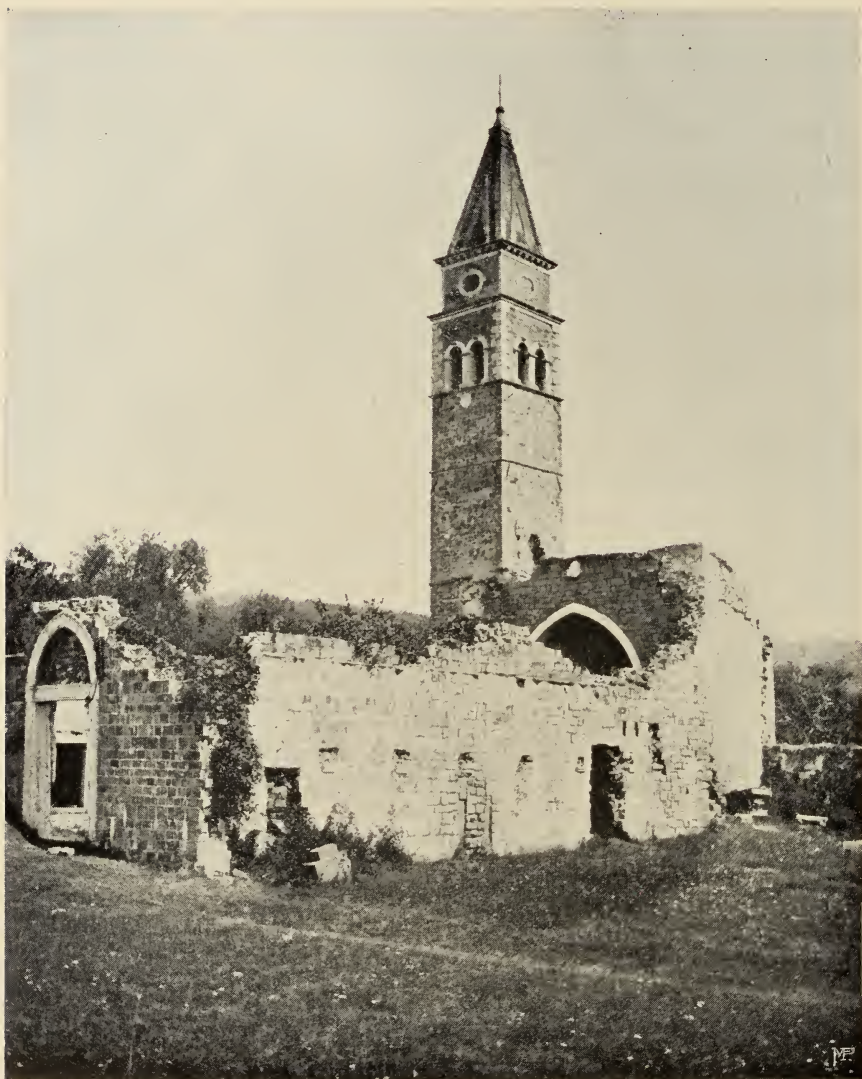
PIRANO: Rovine della chiesa e del convento di San Bernardino. (Fot. A. Pettener, Pirano).
