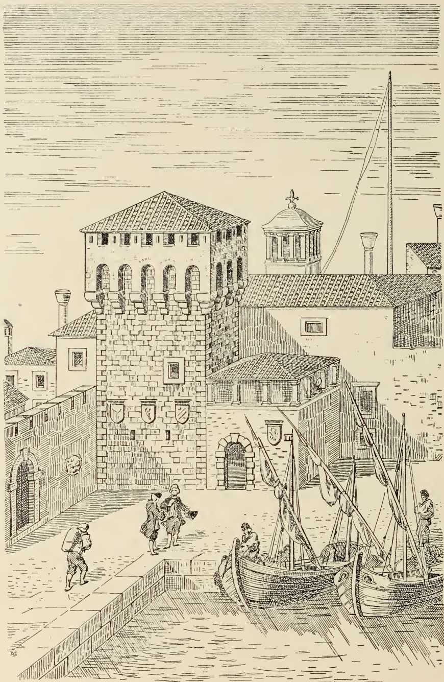
PARENZO: TORRE E TERRAZZINO DEL PALAZZO DEI PODESTÀ (PARTE POSTERIORE).
