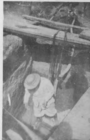
Cemino Azul - Rauch. Hormigonado
