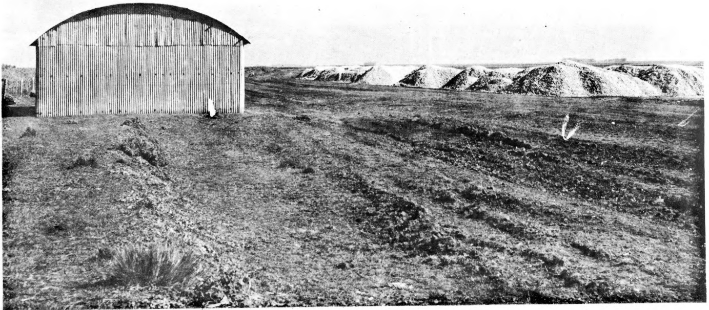
Camino Coronel Suárez - Las Colonias, acopio de materiales
