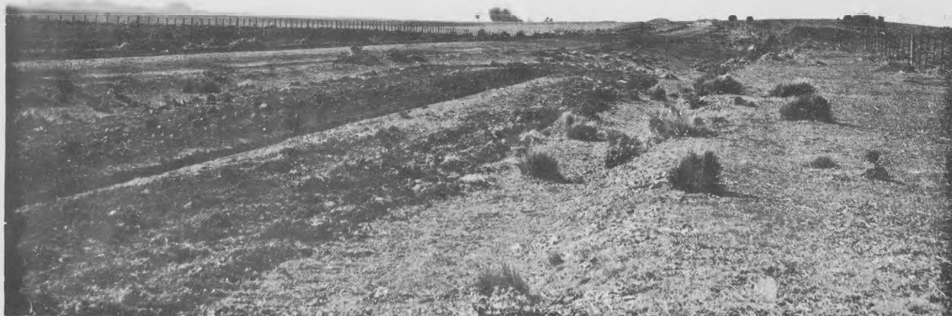
Abovedado existente en el camino Chivilcoy - Chacabuco, ensanchado
