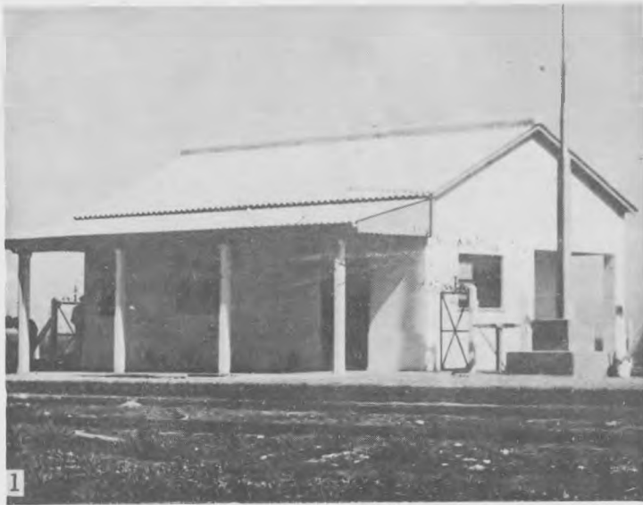
1. - Estación 347 - Olavarría - Loma Negra
