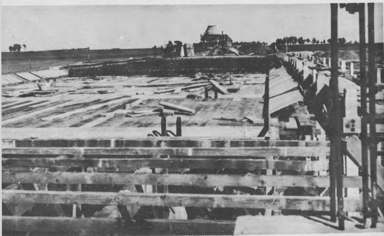
Alcantarilla sobre Río Samborombón Encofrado y Armadura
