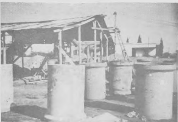
Fabricación de caños de desagües
