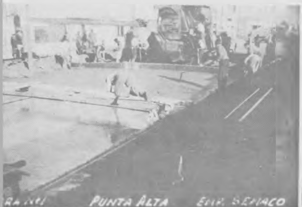
Colocación de moldes para juntas
