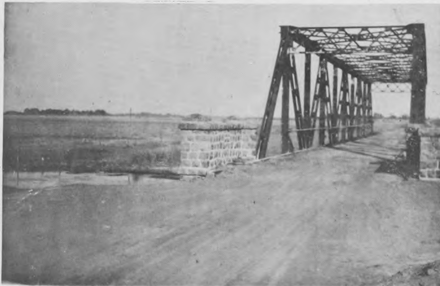
Camino Saladillo - 25 de Mayo (trabajos ejecutados)
