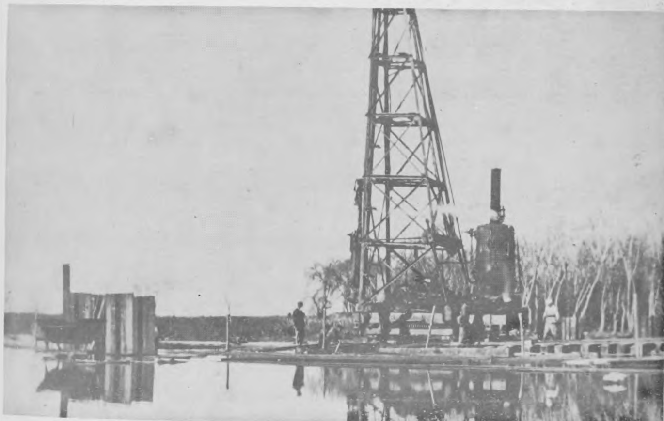
Toma de agua. Punta Lara. Hincia de tablestacado de hierro durante una crecida
