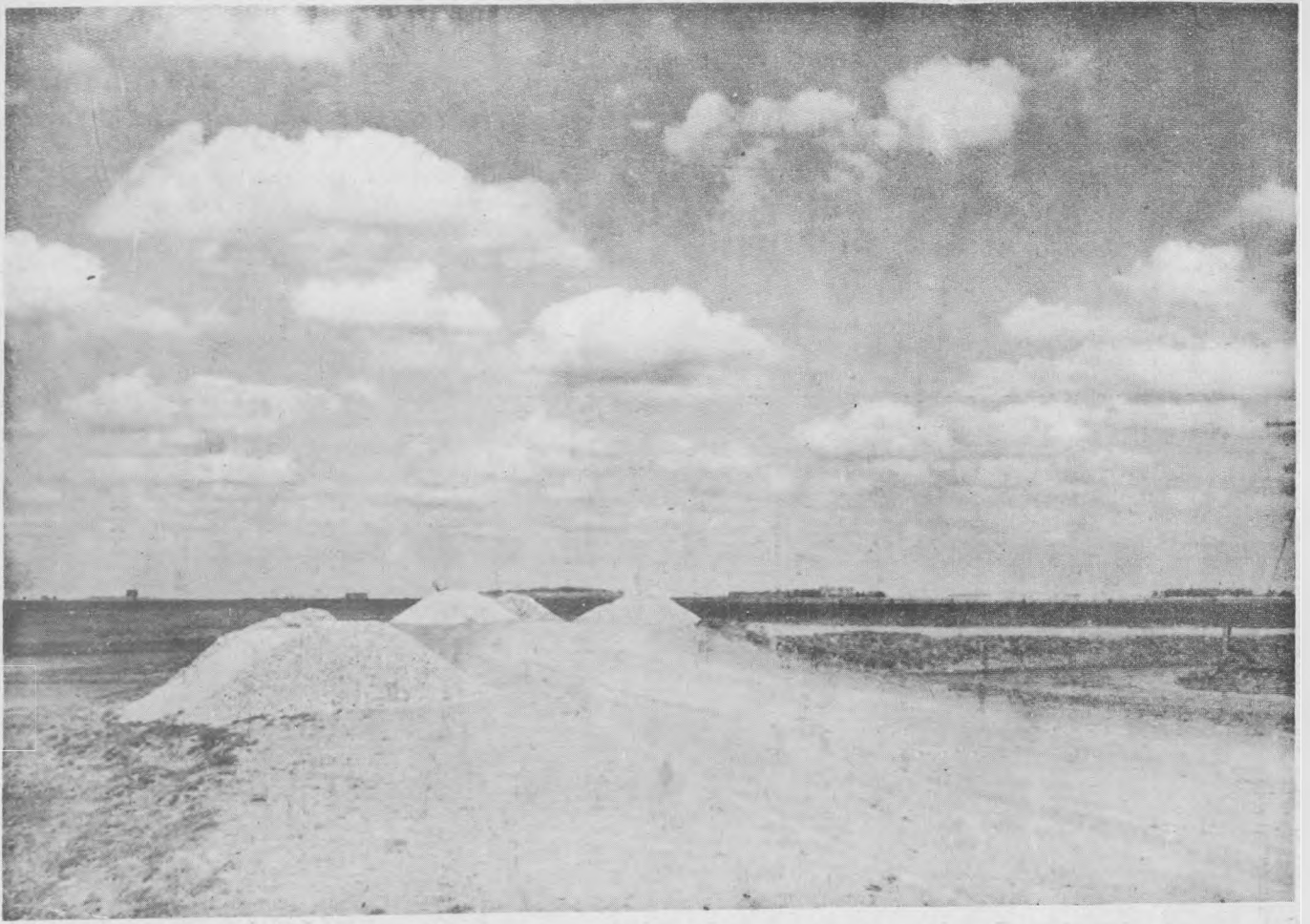
Acopio de materiales para el camino Dolores al Costenero Sud
