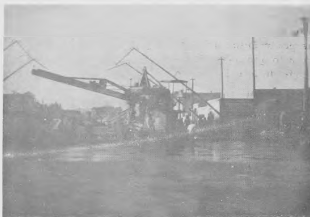
Pavimento de base en construcción
