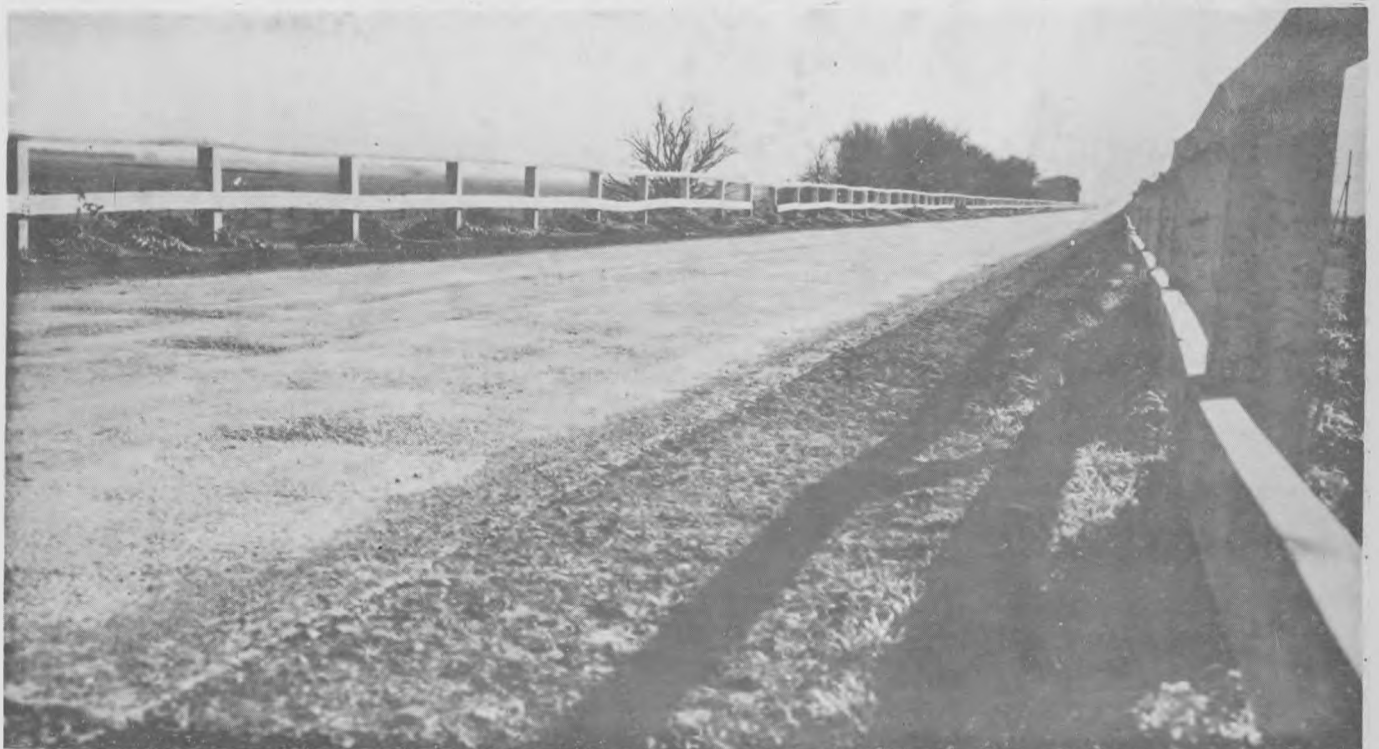
Acceso al puente sobre Río Samborombón.
