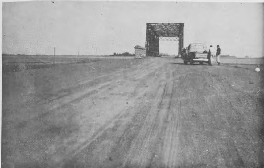
Camino Saladillo - 25 de Mayo (trabajos ejecutados)
