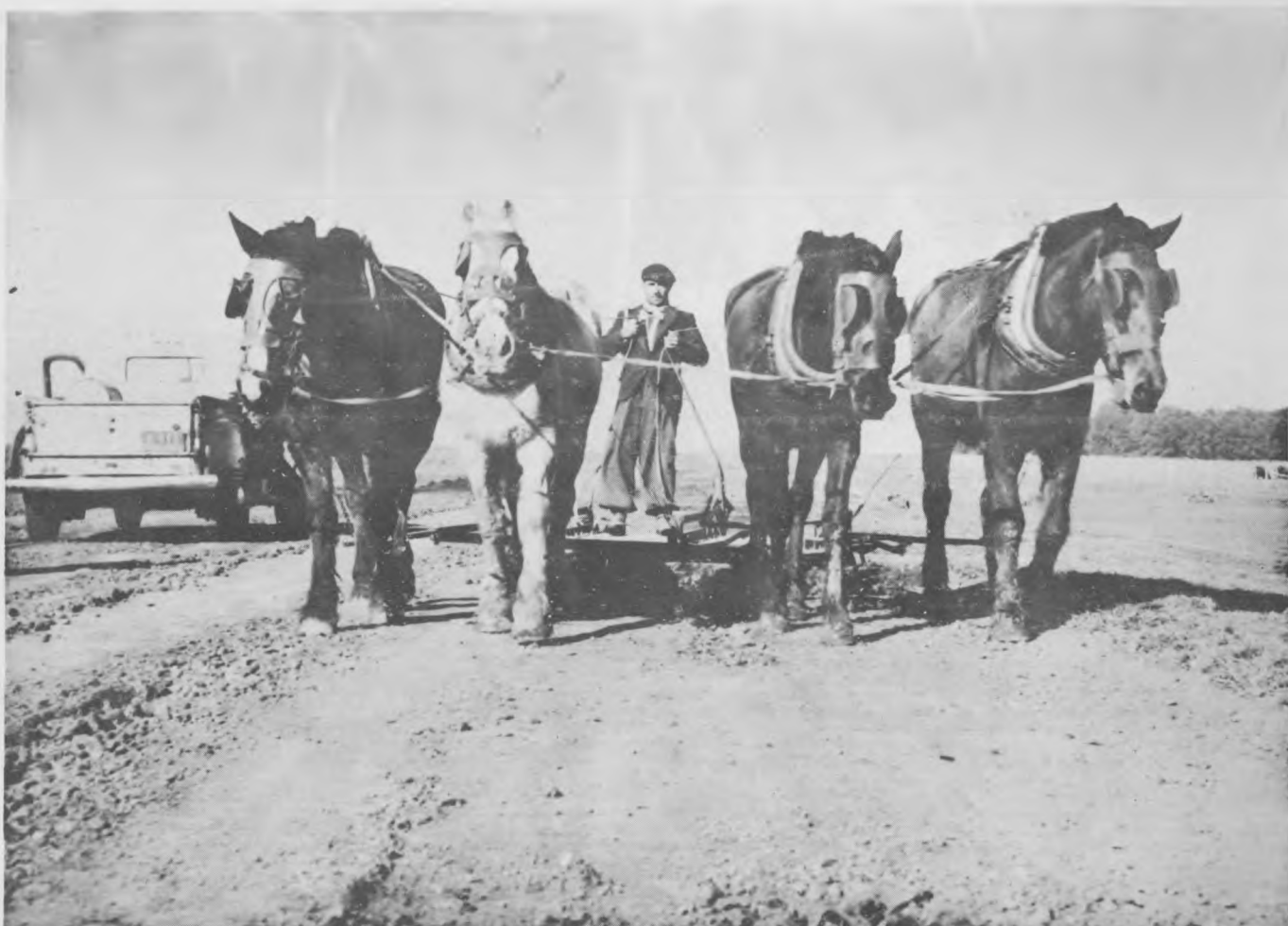
Preparación de base de un terraplén en el Camino Luján - Navarro.
