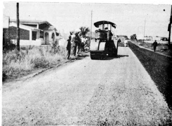
Camino Quilmes (Riego bituminoso)
