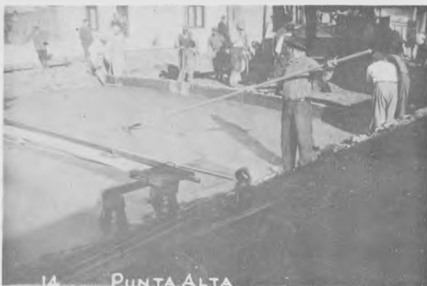
Remoción de instalaciones
