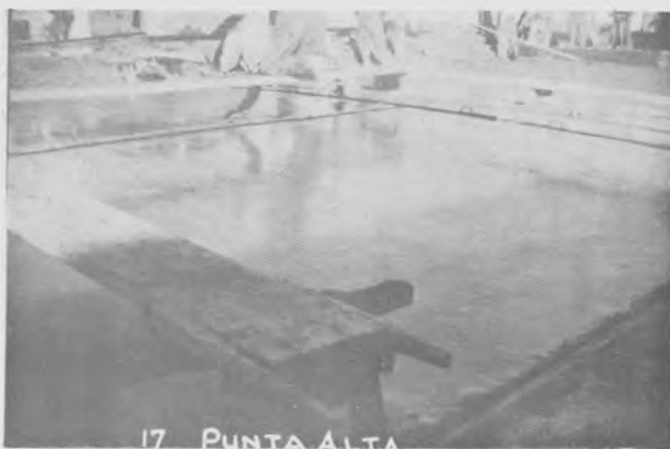
Apisonado y alisado del pavimento
