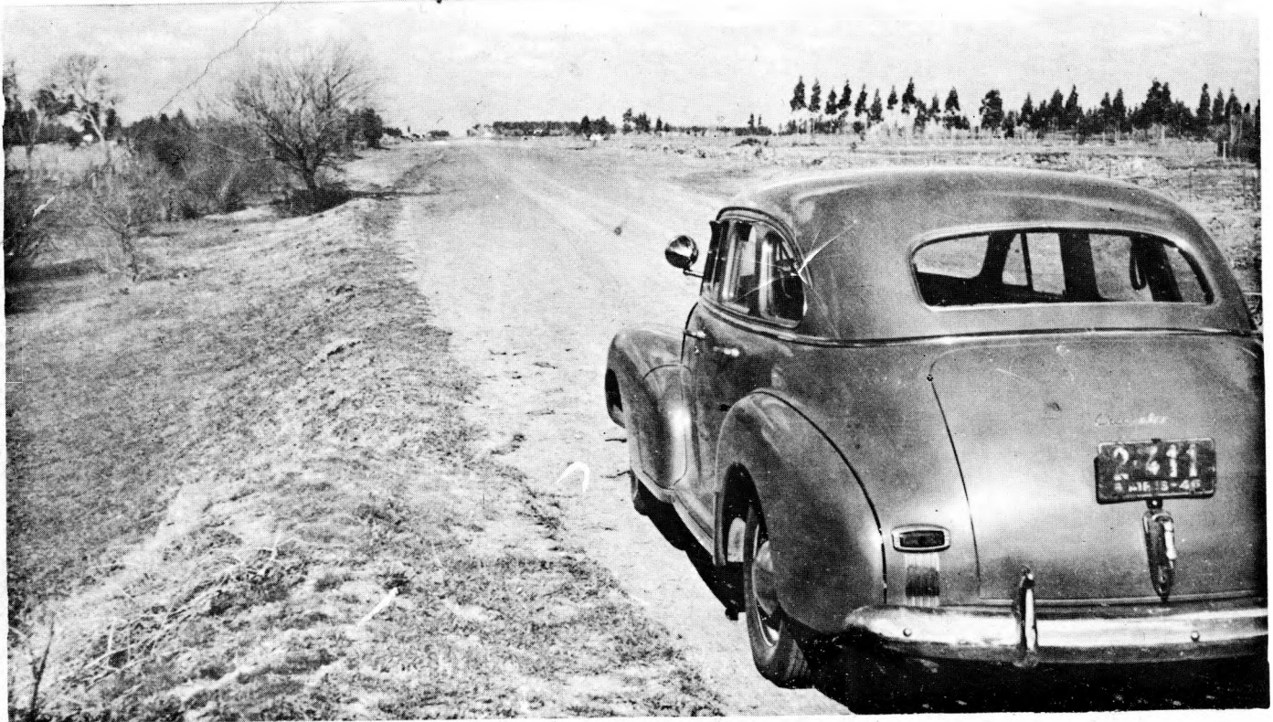
Terraplenes existentes en la traza que se abrirá del Camino Magdalena-Chascomús.
