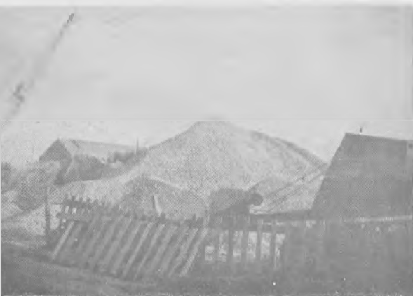
Vista parcial del obrador
