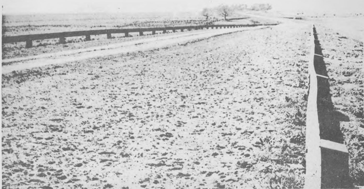
Terraplén defendido en el Camino Azul-Rauch
