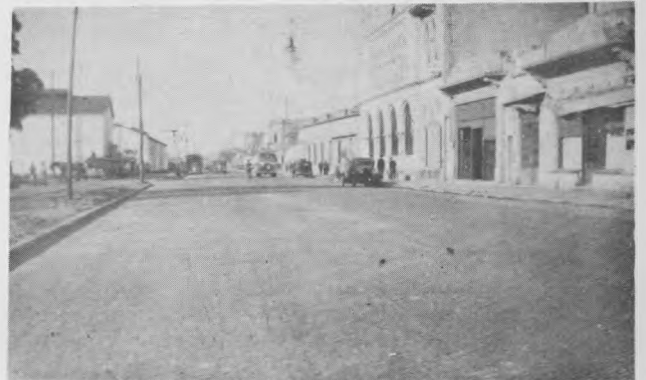
Pavimento de granitullo
