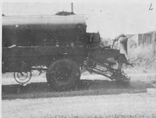
Camino Quilmes (Ruta 1 y 2 riego bituminoso de mejora progresiva)
