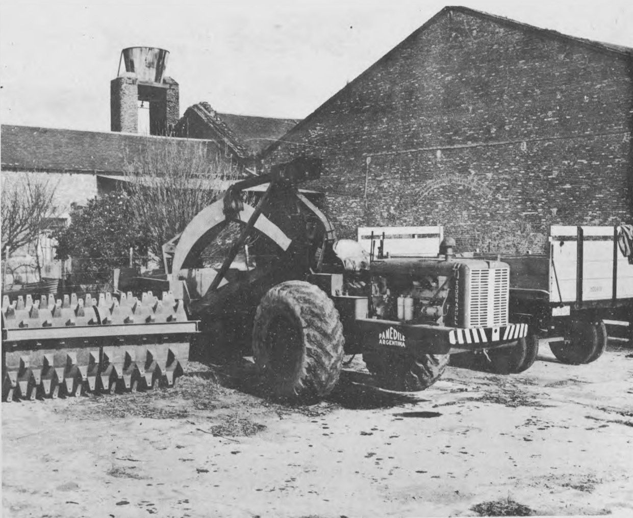
Equipo de compactación en el obrador del Camino Ayacucho - Rauch.
