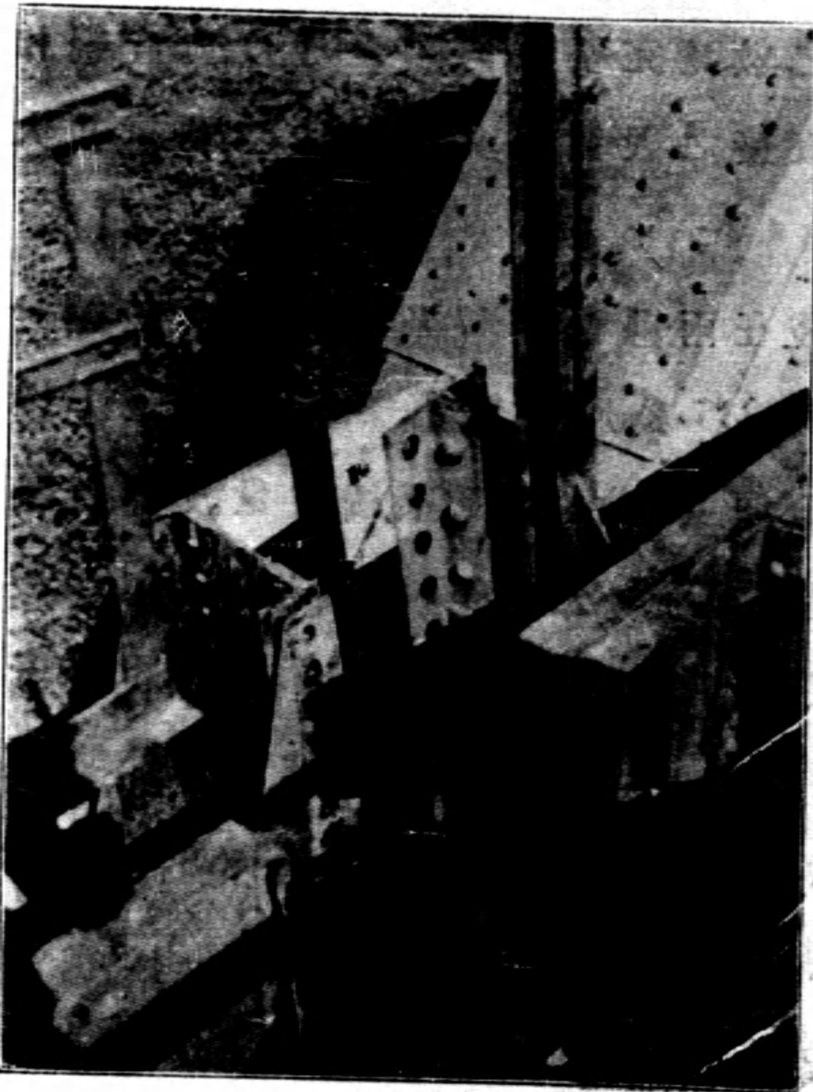
照片四. 第八空單式橋西面橋架之 南端橋梁與下肢脫離接合情形
