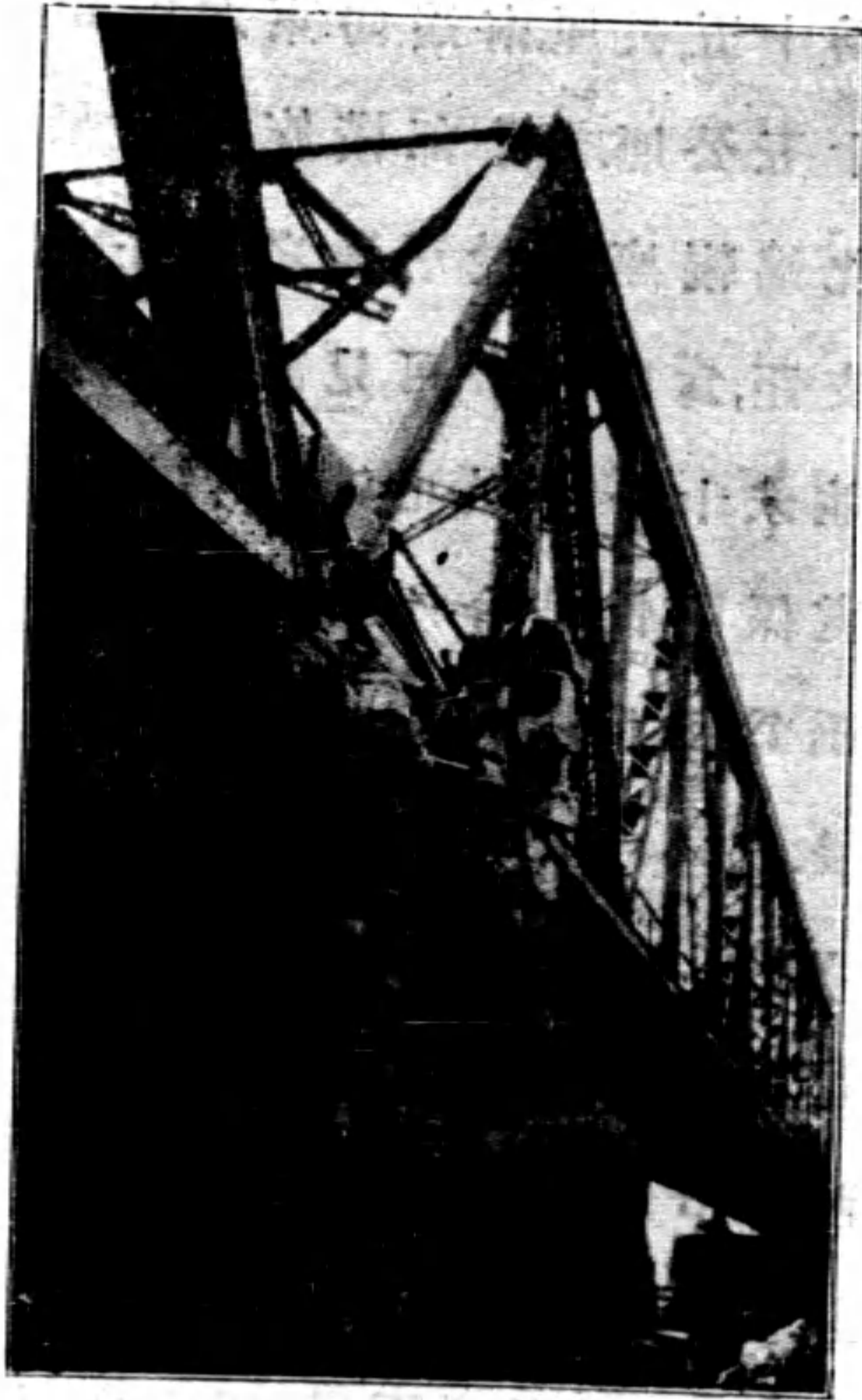
照片五. 毀壞錨臂空之西面梁架之底面觀
