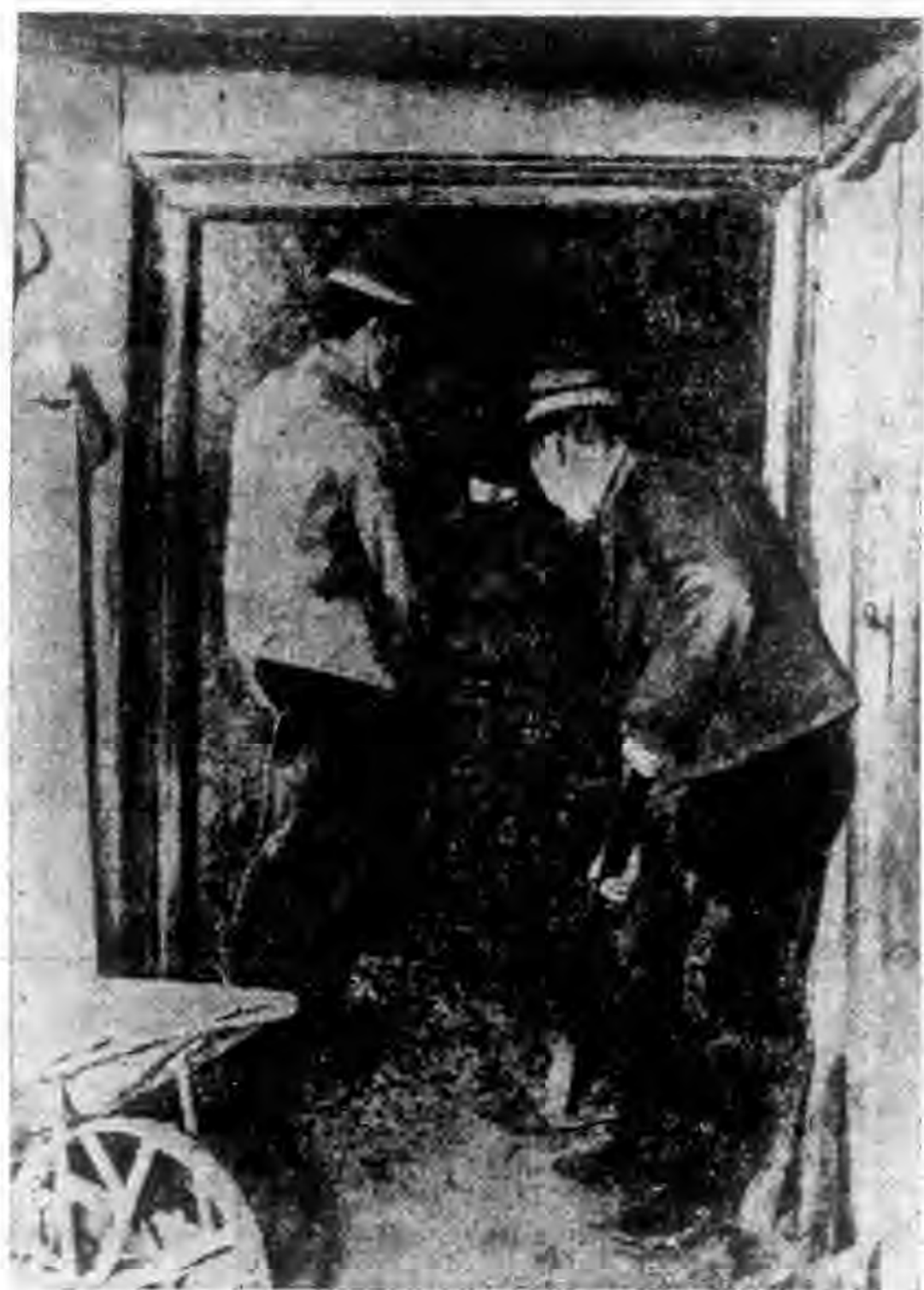
土泥掘挖內道地在兵工
