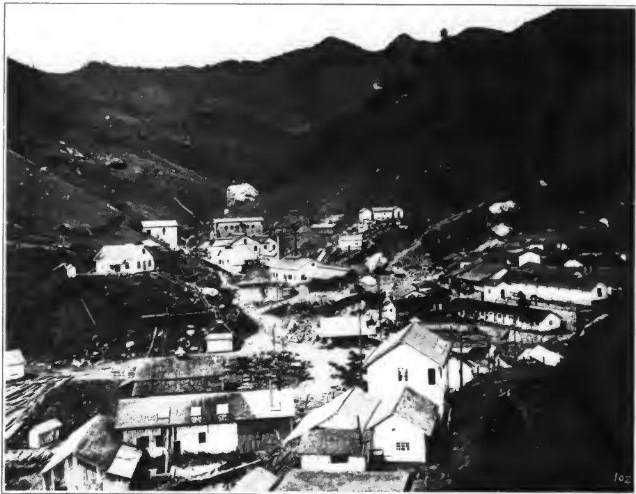
INSTALAÇÃO DA COMPANHIA MINEIRA DE ROSARIO EM SAN JUANCITO, HONDURAS. Esta companhia emprega 900 operarios, e a produçáo annual das minas sobe a $1,500,000.
