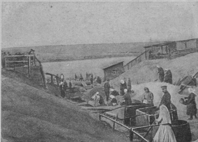
Сооруженіе желѣзо-бетоннаго моста на р. Хоперь, въ г. Балашовѣ, Саратовской губерніи.
