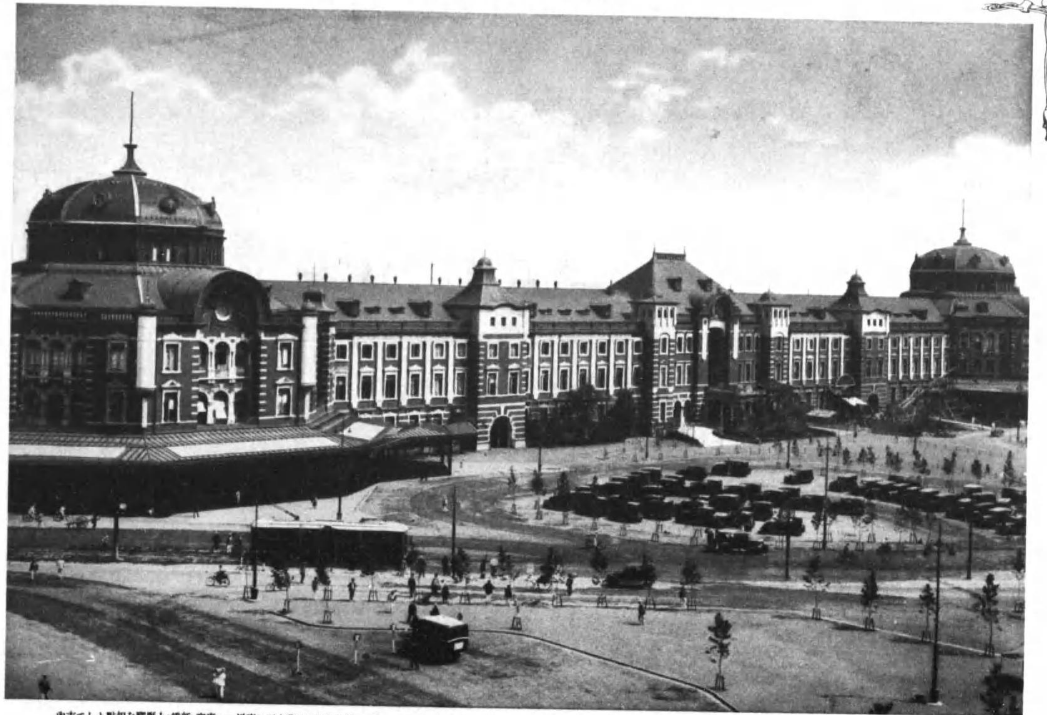
内市てしと點起を野野上・橋新・京東。一洋東に正人萬三十均平客降乘の日一。工竣に年三正大坪餘百六千五坪建てつあで築建式スシラフニルるたり採を長特の場車停名著米歐 (車下門倉田和電市) 驛京東 。錢十五圓三錢し要を開時八。るあが車動自覽遊るす遊題を所名るな主
