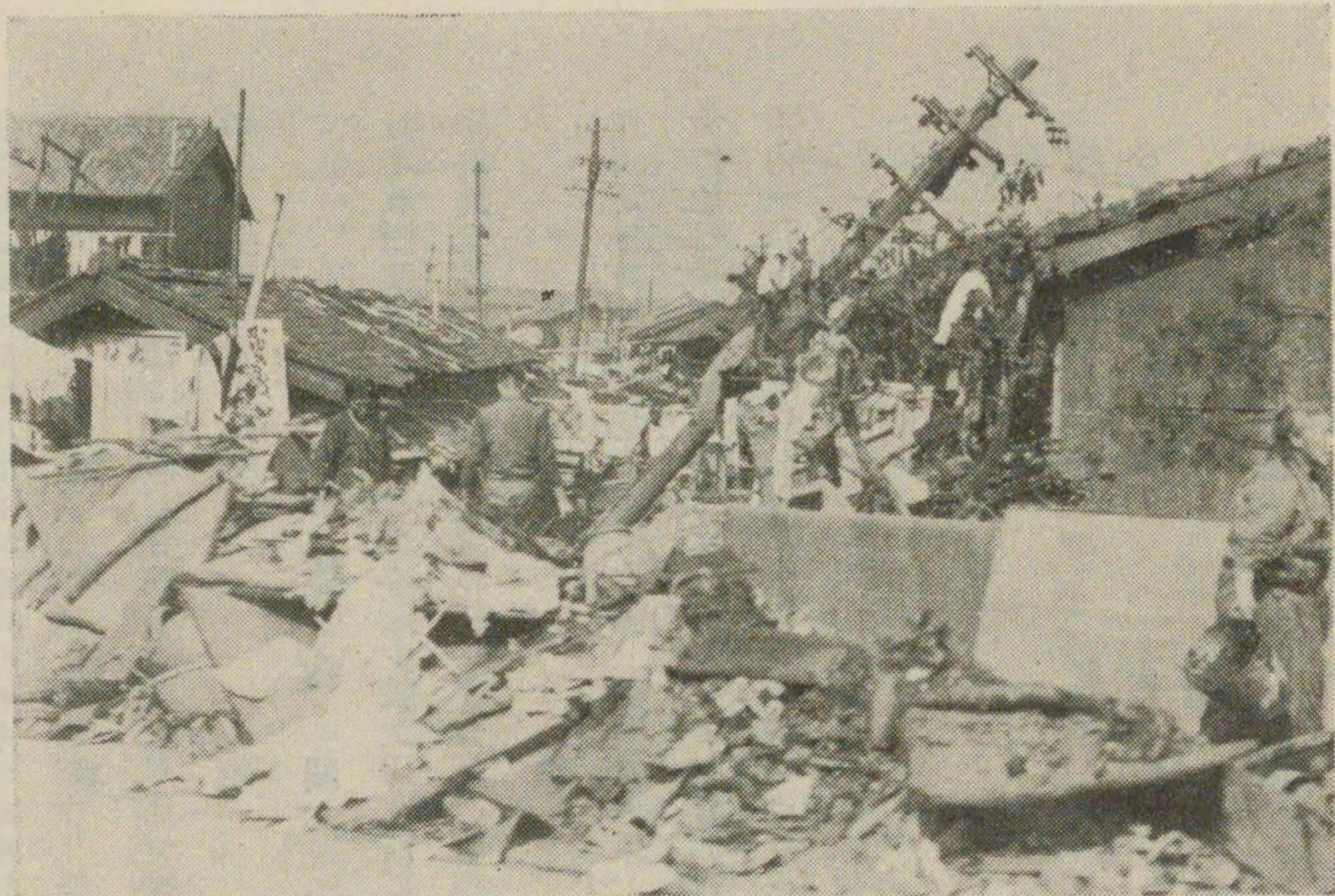
被 害 地 域 の 塵 芥 の 山
