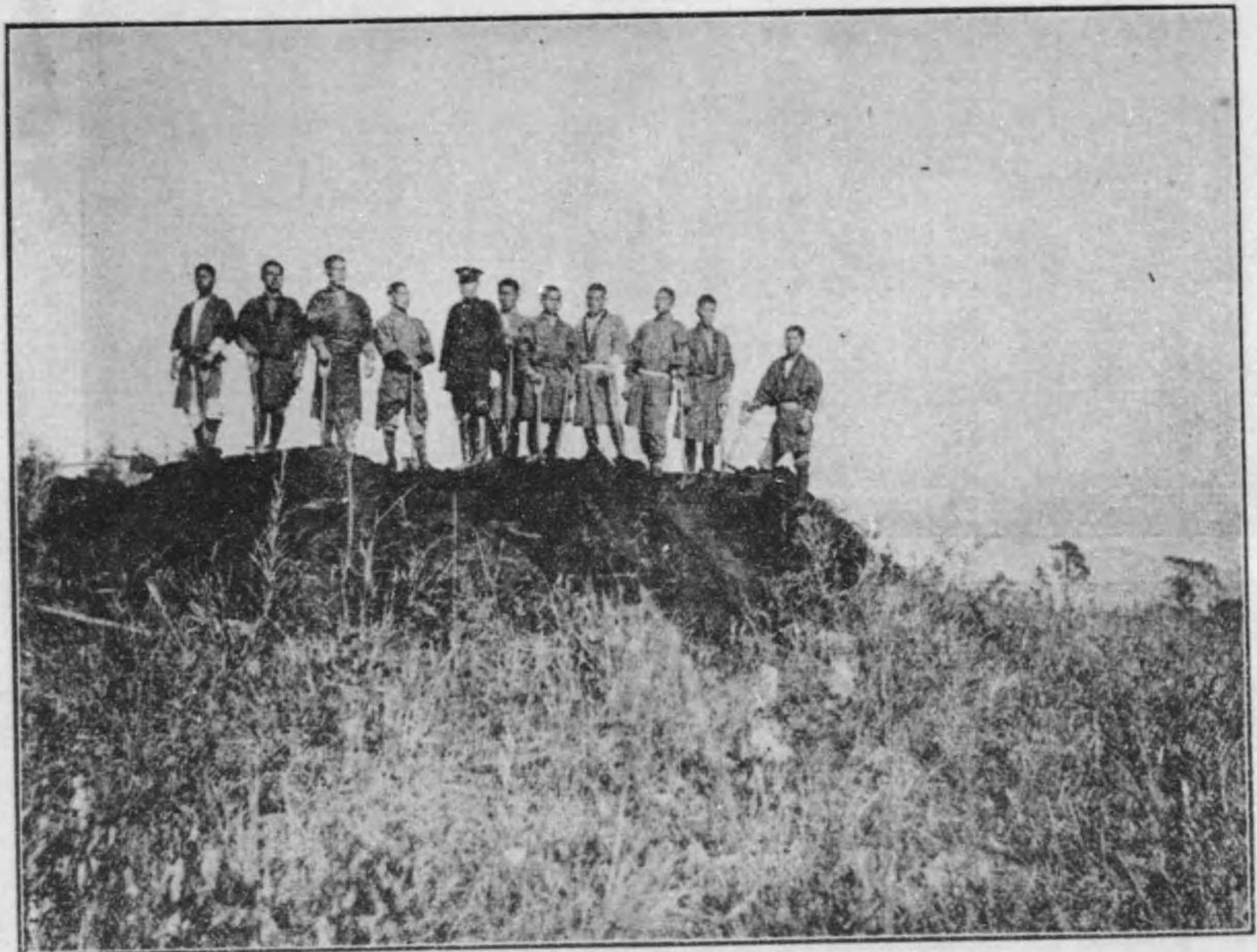
第十七號塚 發掘完成後
