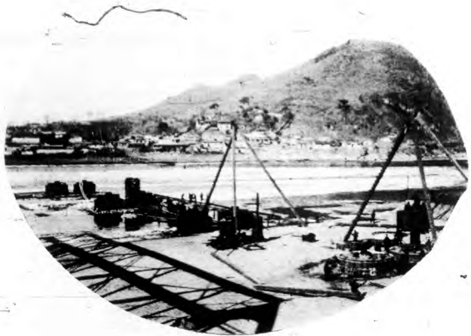
甯路按橋，北局放河，第七號沉箱之情況
