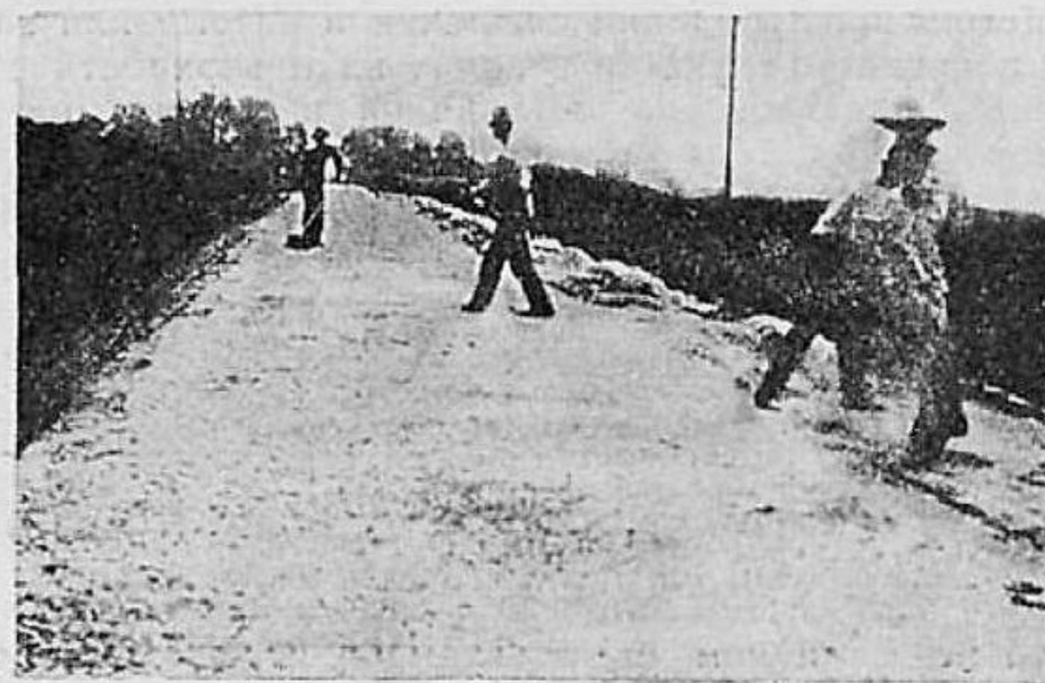
Щебеночное шоссе в различные моменты устройства
