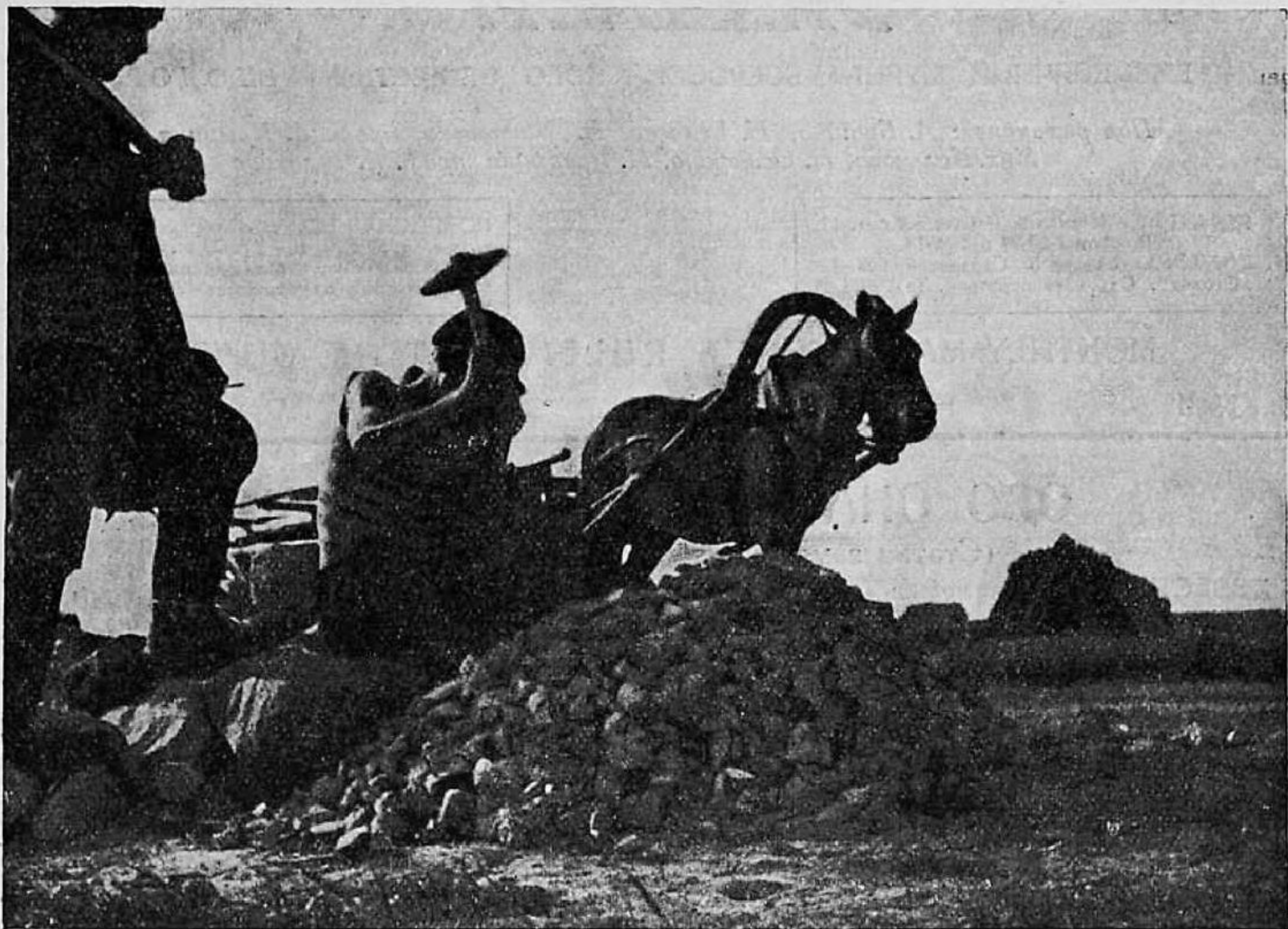
На дорожных работах...
